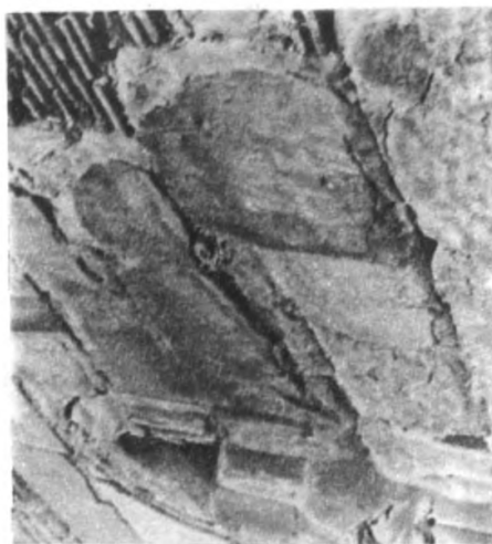
Рис.3. Характерные типы крупных отколов, провалов, отслоения кладки
