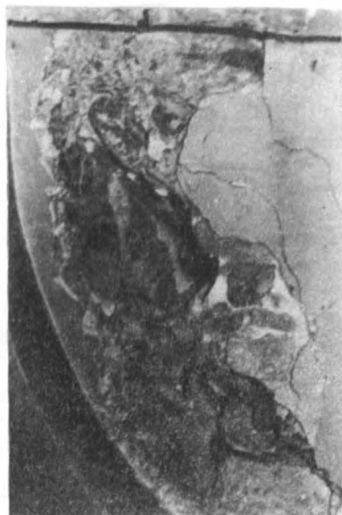
Рис. 2. Трещины, разломы и отколы в арках и сводах а – трещины в швах кладки, выпадение камней, отколы; б – выпучивание кладки, вывалы камней, отколы; в – расслоение кладки по горизонтальному шву; г – расслоение кладки, отколы, обрушение камней, выпучивание (перегрузки, выветривание); д – вертикальная трещина в блоке, расслоение швов; е – трещина и выкол, связанные с перегрузкой, отколы; ж – отколы, выкрашивание, трещины среза; з – косые трещины среза, отколы, расслаивание, смещение камней
