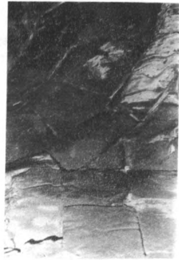
Рис. 2. Трещины, разломы и отколы в арках и сводах а – трещины в швах кладки, выпадение камней, отколы; б – выпучивание кладки, вывалы камней, отколы; в – расслоение кладки по горизонтальному шву; г – расслоение кладки, отколы, обрушение камней, выпучивание (перегрузки, выветривание); д – вертикальная трещина в блоке, расслоение швов; е – трещина и выкол, связанные с перегрузкой, отколы; ж – отколы, выкрашивание, трещины среза; з – косые трещины среза, отколы, расслаивание, смещение камней
