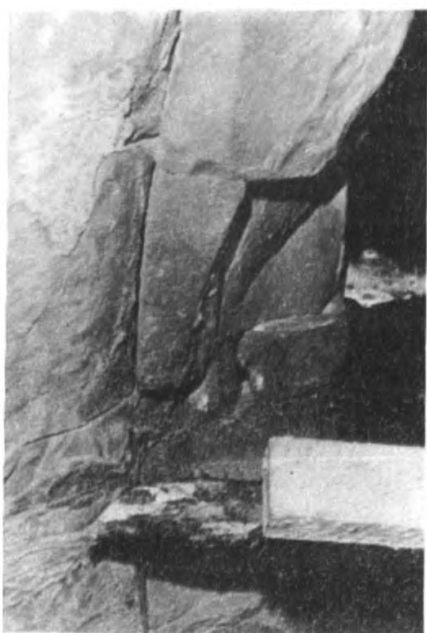
Рис.3. Характерные типы крупных отколов, провалов, отслоения кладки
