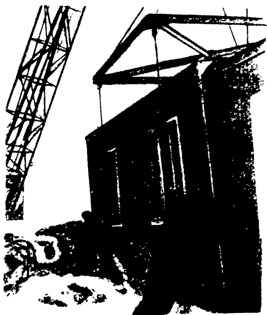
Рис.18. Применение специальной траверсы для монтажа контейнерных зданий
