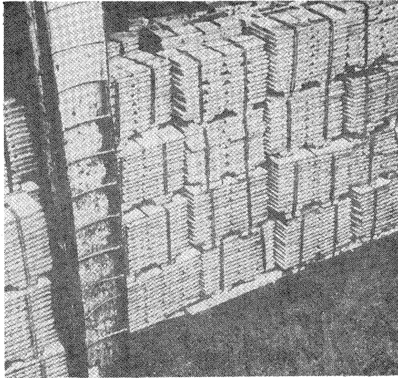
Рис. П102.2. Штабель пакетов цинка в подпалубном пространстве судна. Порт Ленинград
