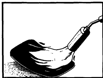
Рис. 4. Прогрев заплата из термоусаживающейся ленты
