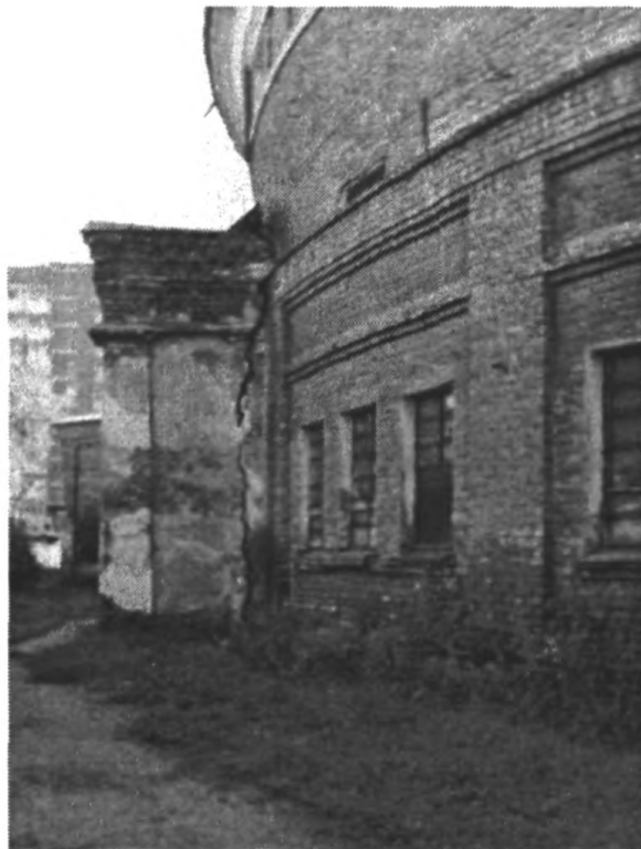
Рис. 28. Отделение выходного тамбура от стены Ижевского цирка.
