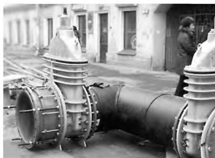
Фото 1.5 Пример фланцевого соединения ПЭ труб и стандартной запорной арматуры
