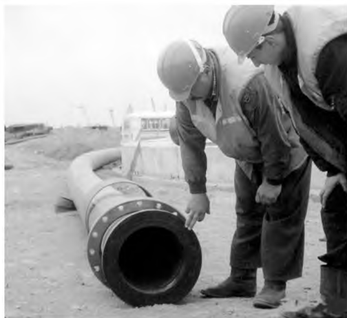
Фото 1.4 Разъемное фланцевое соединение ПЭ труб
