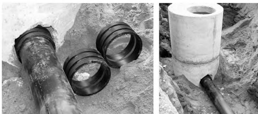
Фото 2.1 Защитные муфты для входа в бетонный колодец
