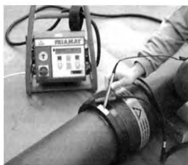
Фото 4.2.4 Сварка муфтой с ЗН
