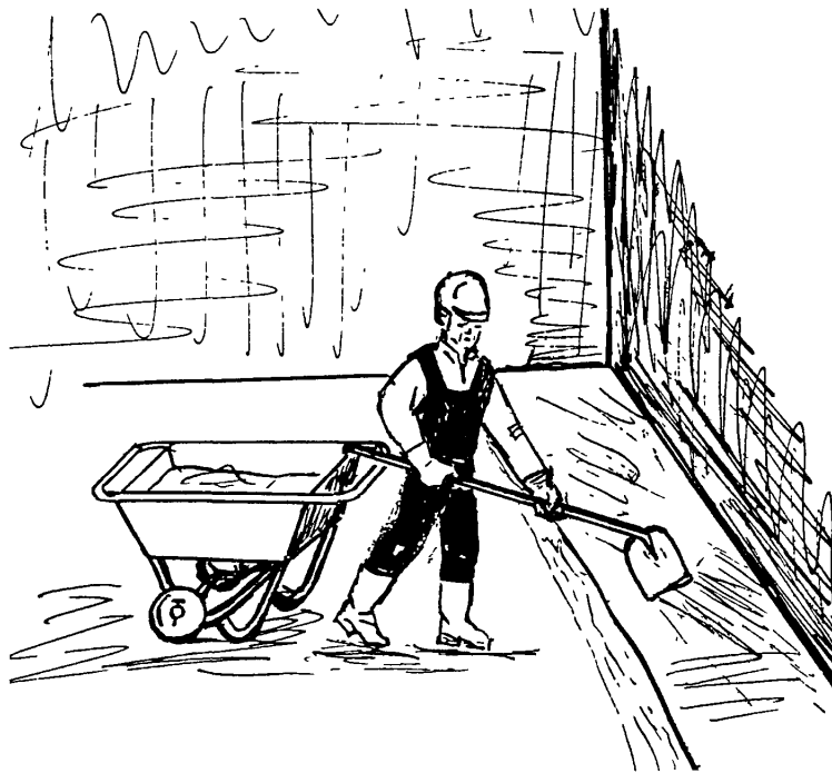
Рисунок 11 – Укладка раствора под мраморные плиты
