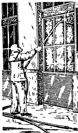
Рис. 2. Пескоструйная очистка фасада.
