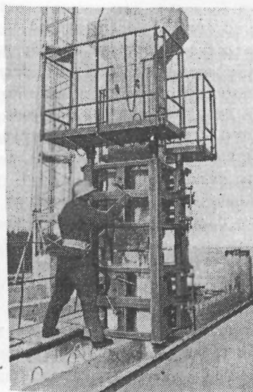
Рис. 6. Полуавтоматический кондуктор для монтажа колонн каркасов серии ИИ 20/70, I. 420-6, I. 420-12 и I. 420-14
