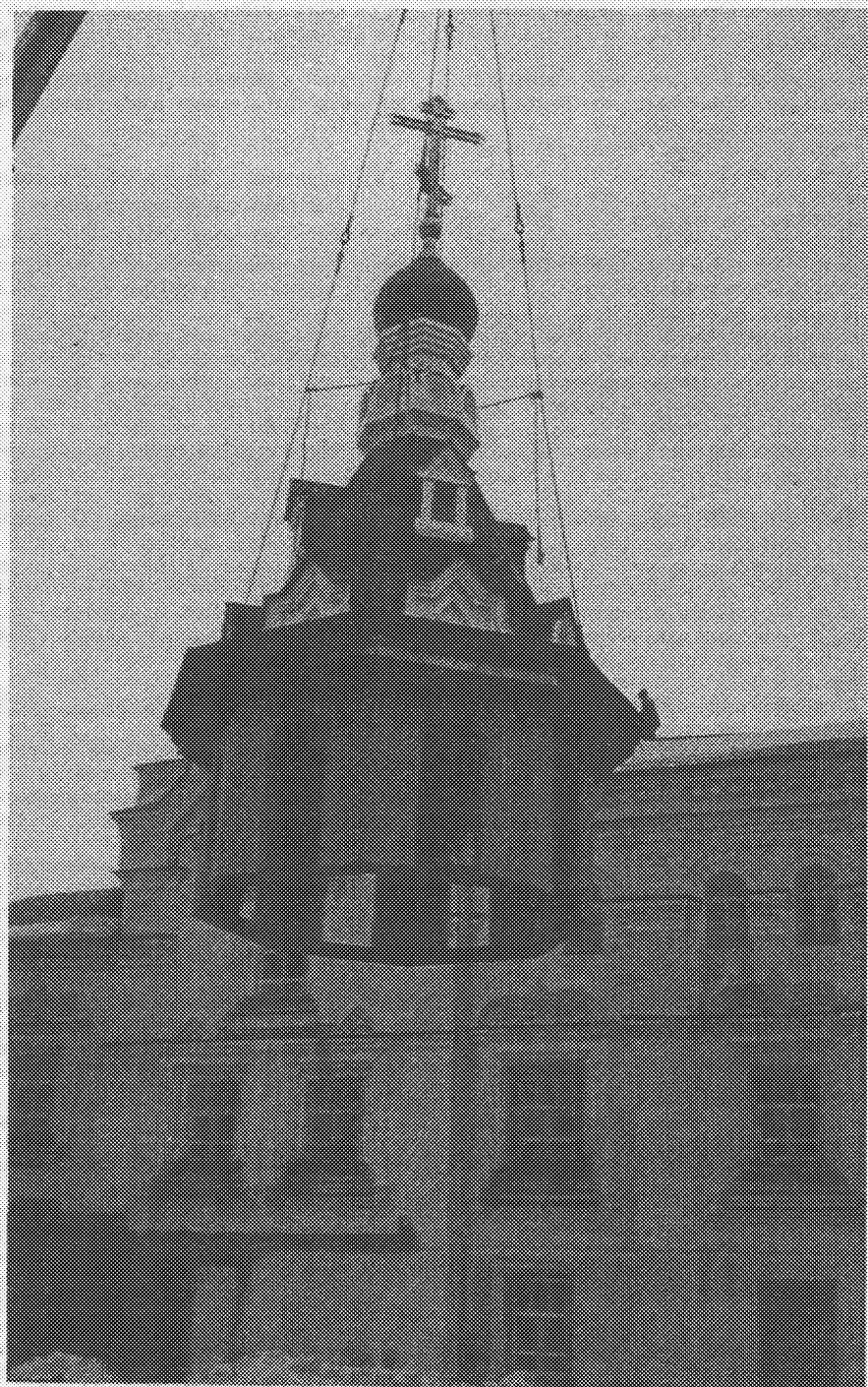
Рис. 59. Подъем готового завершения храма в Свижске, 2001 г.
