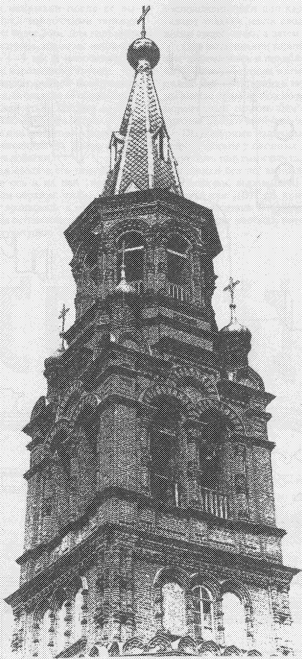
Рис. 23. Колокольня храма в г. Осташкове. Кирпичная кладка фасадов
