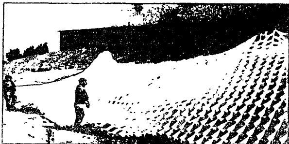
Рис.18. Укладка секций георешеток типа Armatex.
