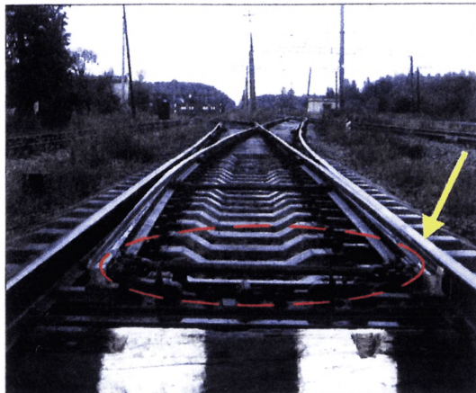
Рис.7.17. Место замера отставания остряка от рамного рельса.
