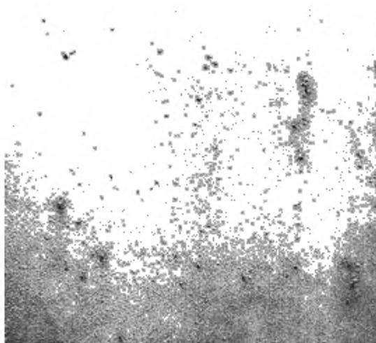
Рисунок 10 — Коррозия металла балл K2 (или R2)
