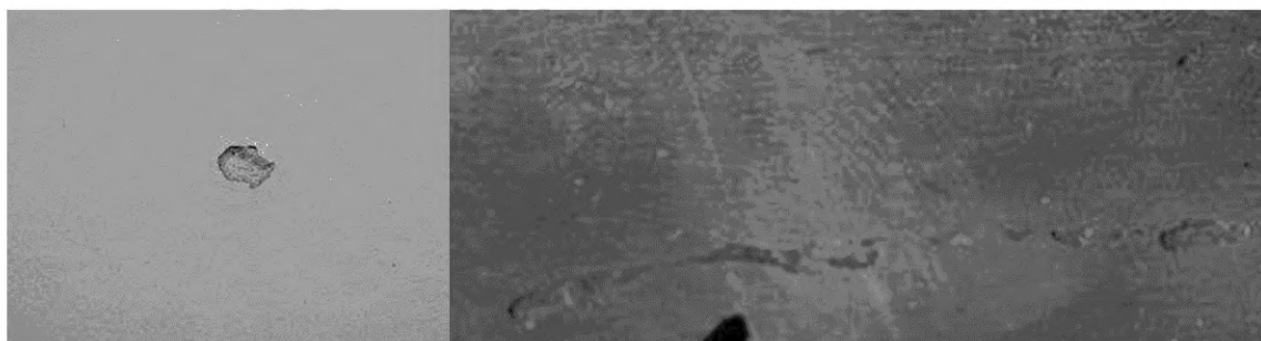
а — внешний вид дефекта в виде углублений
