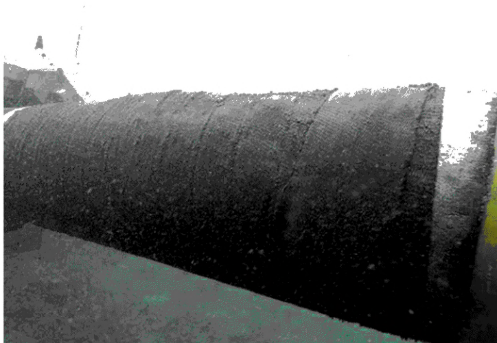
Рисунок А.3 — Общий вид бандаж из композитного материала
