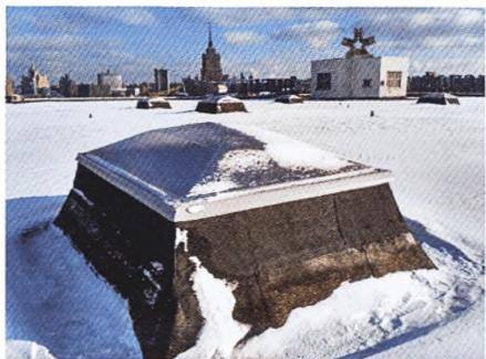
**Дымовые люки** являются обязательными элементами систем вытяжной ПВ с естественным побуждением, применяемых, как правило, для удаления продуктов горения при пожаре непосредственно из помещений одноэтажных зданий большого объема.
