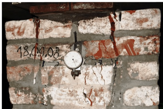
Рисунок 13 – Множественные трещины в кладке, возникшие при испытании на местное сжатие кладки, изготовленной из исторического кирпича
