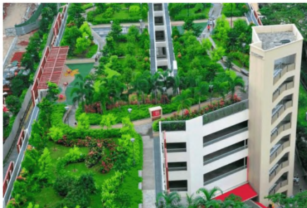
Рисунок Д.4 – Кровля. Общий вид
