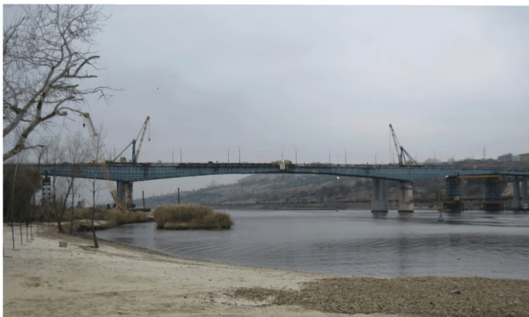
Рисунок Б.17 – Демонтаж Аксайского моста
