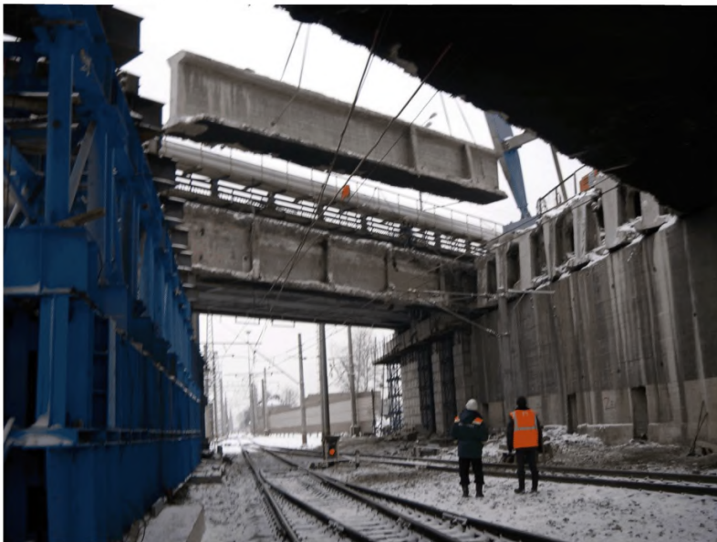
Рисунок Б.19 – Демонтаж Крестовского путепровода в Москве
