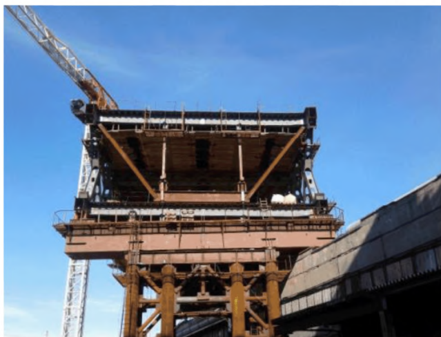
Рисунок Б.9 – Монтаж пролетного строения над производственным зданием
