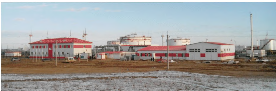
Рисунок 5.3.3 – Вахтовый поселок комплекса нефте-газодобычи
