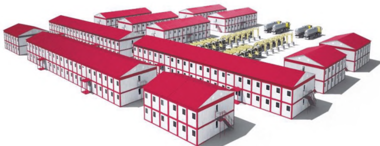
Рисунок 5.18 – Жилой поселок из модульных зданий
