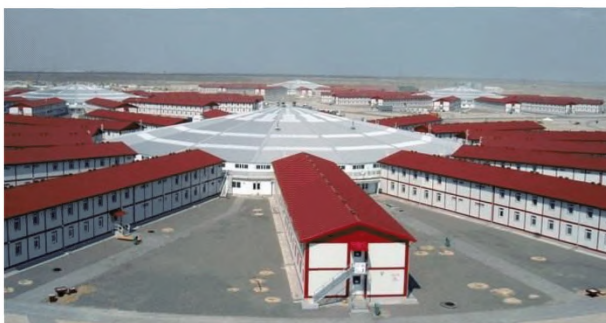
Рисунок 5.17 – Комплекс модульных зданий административно-бытового назначения
