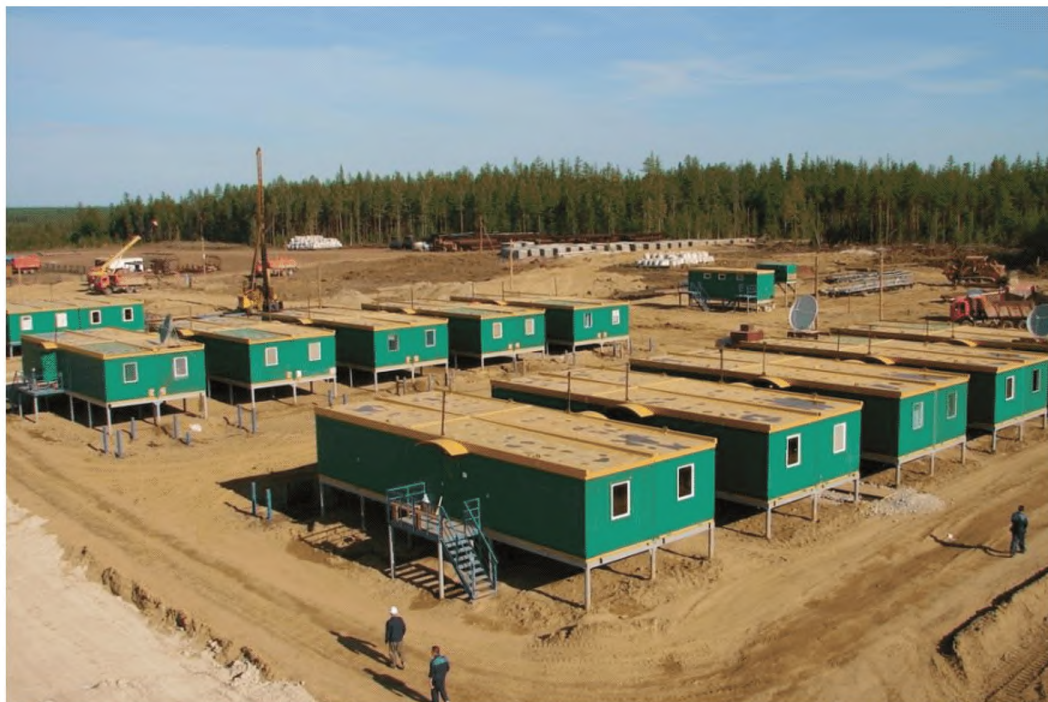
Рисунок 5.3.2 – Строительство вахтового поселка
