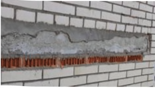
Рисунок А.1.10. Раздробление каменной кладки в уровне междуэтажных перекрытий с полным опиранием облицовочного слоя (с выпуском плит перекрытий или с металлическими уголками) из-за отсутствия горизонтальных деформационных швов
