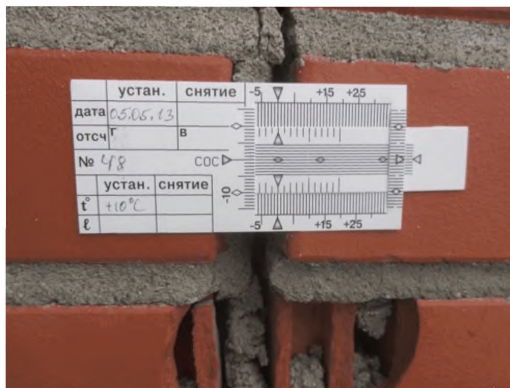
Рисунок 6.1 Пример измерения ширины раскрытия трещин фиксирующим устройством пластинчатого типа
