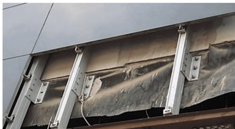
Рисунок В.2. Обрушение облицовки из керамогранита из-за слабого крепления
