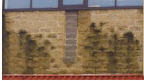
Рисунок А.1.16. Образование высолов и потемнений на поверхности каменного облицовочного слоя
