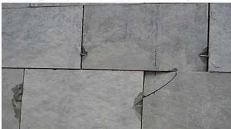
Рисунок В.1. Разрушение керамогранитной облицовки в местах штыревых креплений
