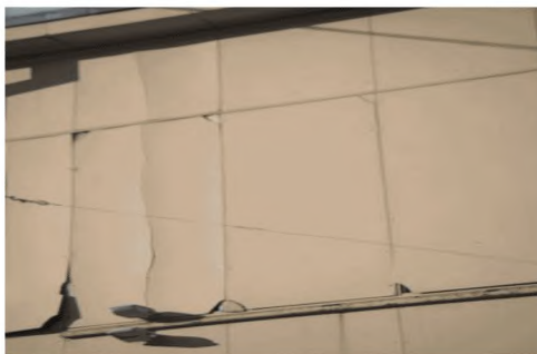
Рисунок В.8. Коробление и растрескивание фиброцементных плит из-за отсутствия температурных пазов в местах крепления к металлическим направляющим
