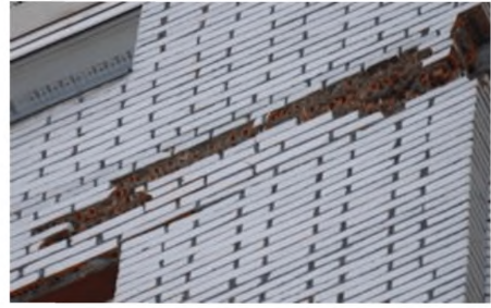
Рисунок А.1.10. Раздробление каменной кладки в уровне междуэтажных перекрытий с полным опиранием облицовочного слоя (с выпуском плит перекрытий или с металлическими уголками) из-за отсутствия горизонтальных деформационных швов
