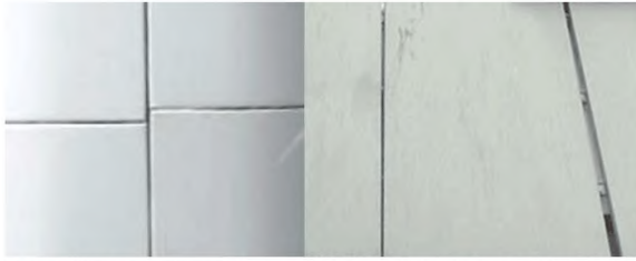
Рисунок В.5. Смещение металлических кассетных плит и неодинаковые зазоры между ними
