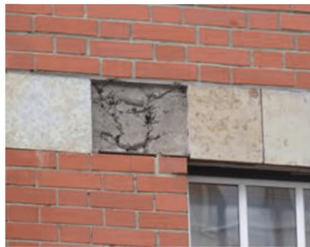
Рисунок А.1.12. Отслоение штукатурки и декоративной облицовочной плитки с торцов монолитных железобетонных перекрытий с полным опиранием облицовочного каменного слоя
