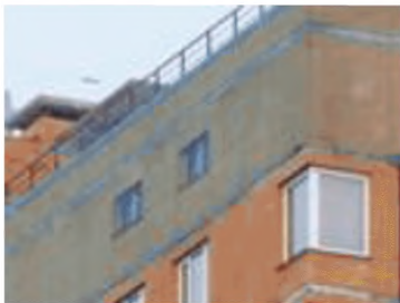
Рисунок Б.10. Установка защитных полимерных сеток, предотвращающих падение поврежденной кладки облицовочного каменного слоя без устранения причин повреждения и восстановления кладки
