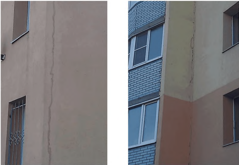
Рисунок Б.8. Дополнительное утепление фасада с оштукатуриванием тонким слоем без усиления армирования в угловых зонах здания
