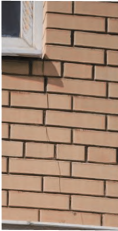
Рисунок А.1.6. Вертикальные и наклонные трещины на прямых участках стен в угловых зонах оконных проемов вследствие различных деформаций кладки в межоконных поясах и простенках и отсутствия ее армирования
