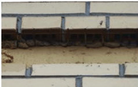
Рисунок А.2.2. Заполненные строительным раствором щели пустотных кирпичей
