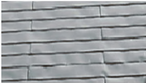
Рисунок В.7. Коробление металлических облицовочных плит из-за отсутствия температурных пазов в местах крепления к металлическим направляющим
