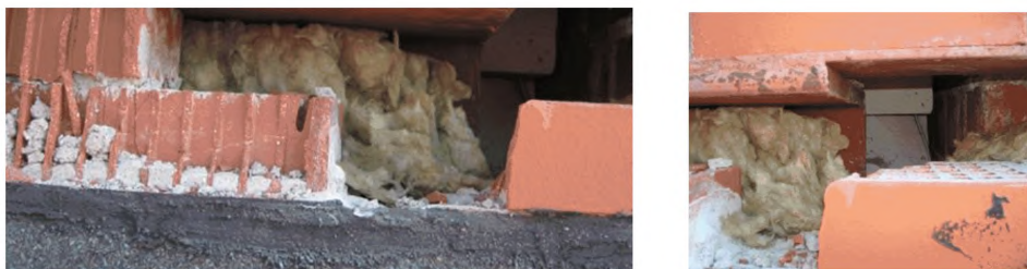
Рисунок А.2.6. Некачественный монтаж слоя теплоизоляции
