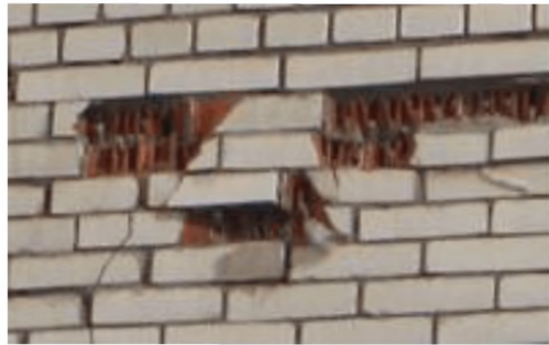
Рисунок А.1.11. Раздробление каменной кладки в уровне междуэтажных перекрытий с неполным опиранием облицовочного слоя (с транзитными участками) из-за отсутствия горизонтальных деформационных швов
