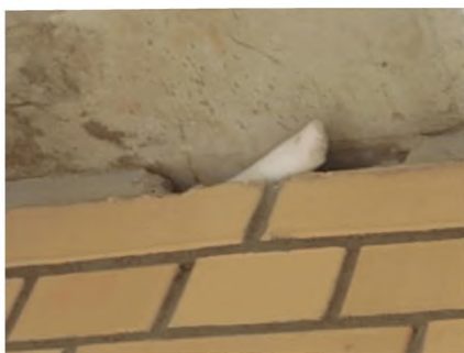
Рисунок А.2.4. Неправильная герметизация горизонтальных деформационных швов с внешней стороны облицовочного каменного слоя: а - заполнение кладочным раствором вместо податливого герметика, б - отсутствие герметика
