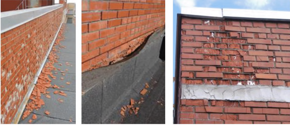
Рисунок А.1.14. Разрушение каменной кладки парапетов кровли в результате ее размораживания
