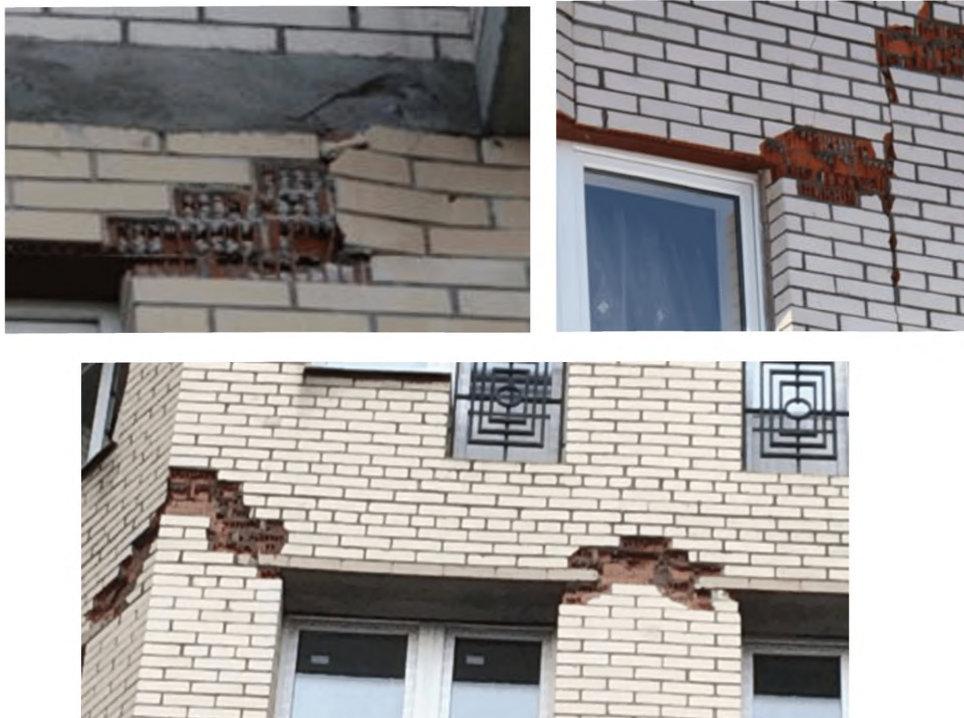
Рисунок А.1.8. Разрушение кладки лицевого слоя в зоне перемычек в результате образования трещин и последующего размораживания
