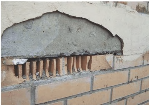
Рисунок А.1.12. Отслоение штукатурки и декоративной облицовочной плитки с торцов монолитных железобетонных перекрытий с полным опиранием облицовочного каменного слоя
