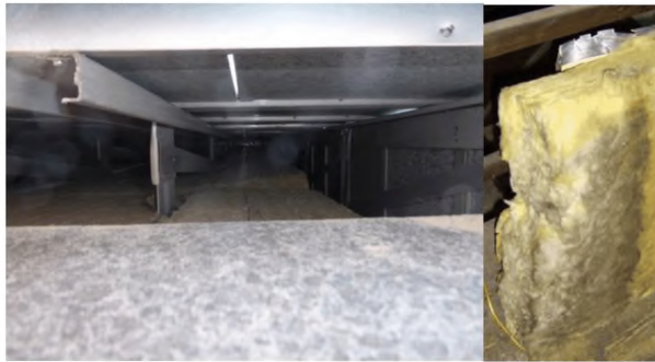
Рисунок В.10. Отсутствие ветровлагозащитной мембраны и увлажнение теплоизоляционного слоя
