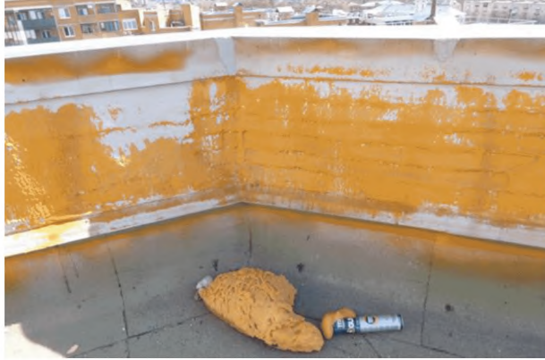
Рисунок Б.7. Ремонт поврежденной размораживанием кладки парапетов кровли путем нанесения слоя монтажной пены
