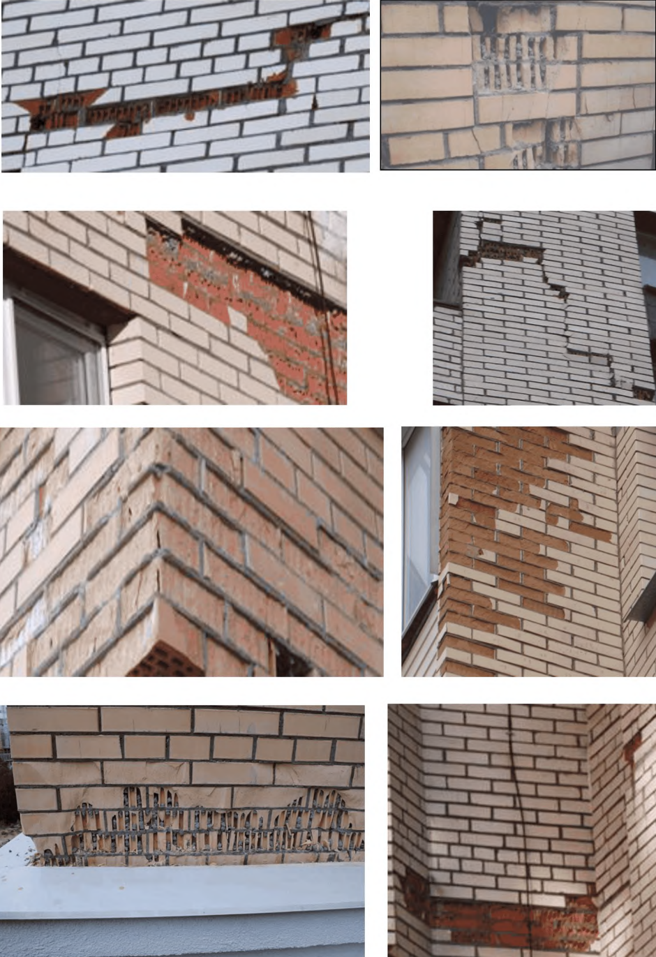
Рисунок А.1.13. Разрушение кладки облицовочного каменного слоя в результате ее размораживания
