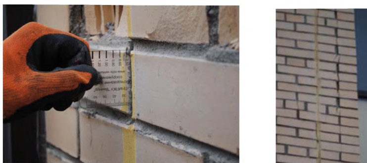
Рисунок Б.3. Прорезка вертикальных деформационных швов не на всю толщину облицовочного каменного слоя
