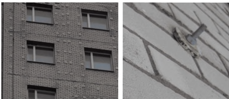
Рисунок Б.5. Установка чрезмерно жестких на сдвиг в плоскости стены и выступающих наружу металлических ремонтных связей, соединяющих облицовочный и внутренний каменные слои
