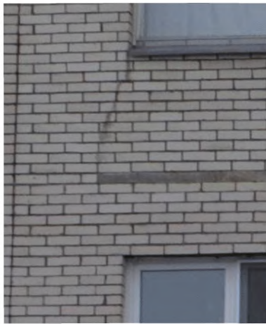
Рисунок А.1.6. Вертикальные и наклонные трещины на прямых участках стен в угловых зонах оконных проемов вследствие различных деформаций кладки в межоконных поясах и простенках и отсутствия ее армирования
