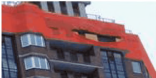
Рисунок Б.10. Установка защитных полимерных сеток, предотвращающих падение поврежденной кладки облицовочного каменного слоя без устранения причин повреждения и восстановления кладки
