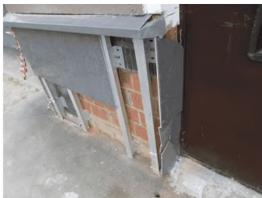
Рисунок В.3. Разрушения облицовки из керамогранита в цокольной части здания из-за механических воздействий
