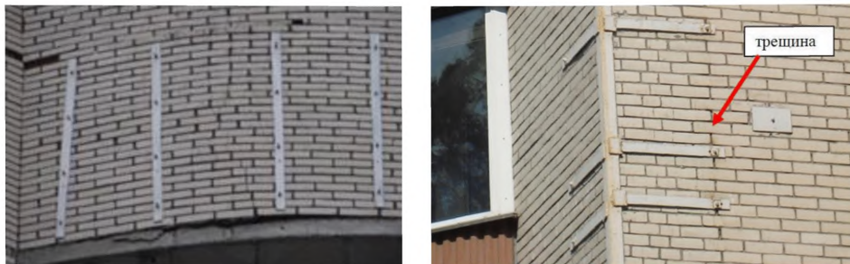
Рисунок Б.1. Укрепление участков облицовочного слоя с трещинами металлическими обоймами
