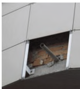
Рисунок В.4. Локальное удаление керамогранитной плитки с целью устройства водоотвода с лоджии
