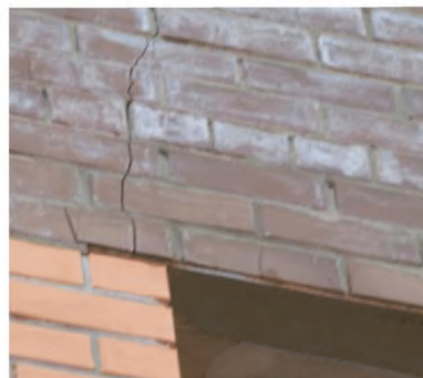
Рисунок А.1.7. Вертикальные и наклонные трещины в зоне железобетонных и стальных перемычек вследствие разности их температурных деформаций и каменной кладки
