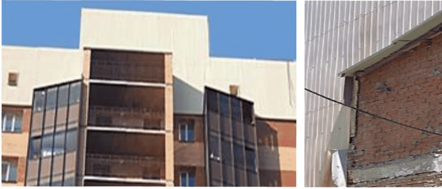
Рисунок Б.9. Защита поврежденного облицовочного каменного слоя сэндвич – панелями с низкой паропроницаемостью и высокой деформативностью при внешних температурных воздействиях
