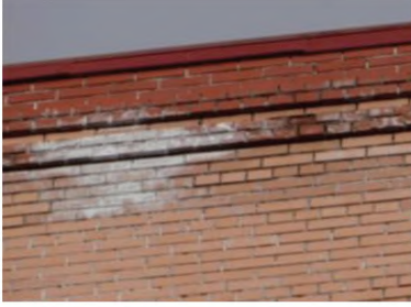
Рисунок А.1.16. Образование высолов и потемнений на поверхности каменного облицовочного слоя
