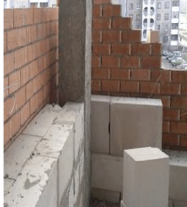
Рисунок А.2.8. Отсутствие вентилируемой воздушной прослойки между облицовочным слоем и внутренним слоем из газобетонных блоков
