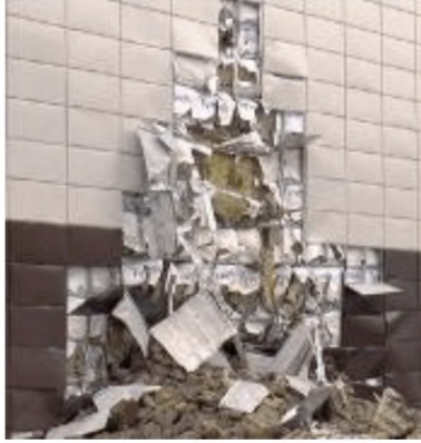
Рисунок В.9. Вывал фрагмента навесной фасадной системы с металлической облицовкой вследствие ненадежного крепления под облицовочного каркаса к основанию (каменной стене)
