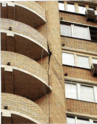
Рисунок А.1.2. Выпучивание облицовочного слоя из-за отсутствия горизонтальных деформационных швов, отсутствия либо недостаточного количества гибких связей: а – в зоне простенков, б – в зоне сопряжений с балконными плитами, в – в зоне железобетонных перекрытий
