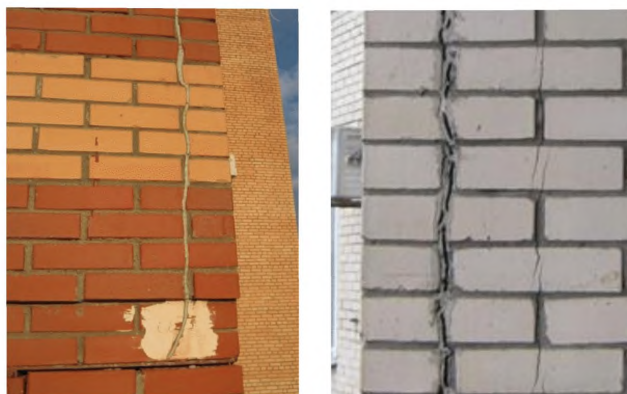
Рисунок Б.2. Герметизация трещин монтажной пеной или неаэроустойчивыми мастиками
