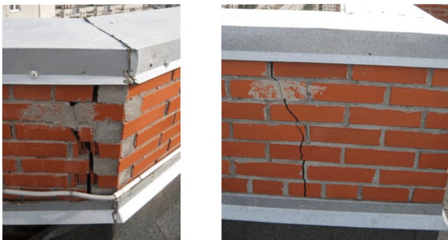
Рисунок А.1.9. Трещины в каменных парапетах кровли из-за отсутствия или недостаточного армирования кладки, отсутствия вертикальных деформационных швов
