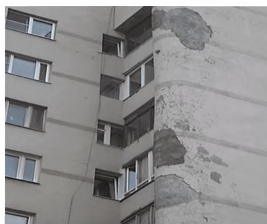
Рисунок Б.6. Оштукатуривание поврежденного облицовочного слоя
