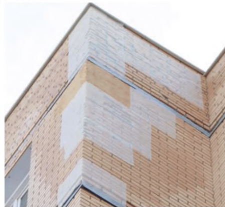
Рисунок Б.9. Защита поврежденного облицовочного каменного слоя сэндвич – панелями с низкой паропроницаемостью и высокой деформативностью при внешних температурных воздействиях
