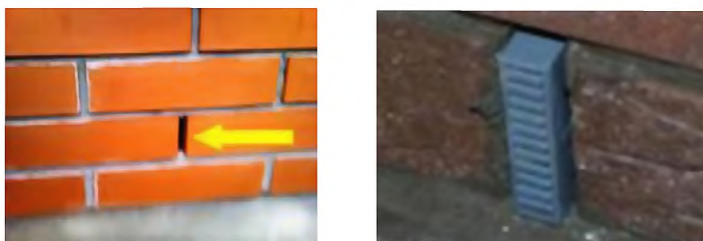
Рисунок 13.2 Устройство вентиляционных продухов в растворных швах
