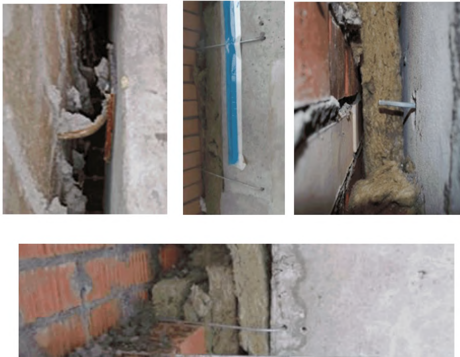
Рисунок А.2.5. Неадекватное крепление лицевого каменного слоя к внутренней железобетонной стене с помощью гибких связей
