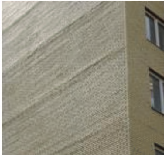
Рисунок А.1.2. Выпучивание облицовочного слоя из-за отсутствия горизонтальных деформационных швов, отсутствия либо недостаточного количества гибких связей: а – в зоне простенков, б – в зоне сопряжений с балконными плитами, в – в зоне железобетонных перекрытий
