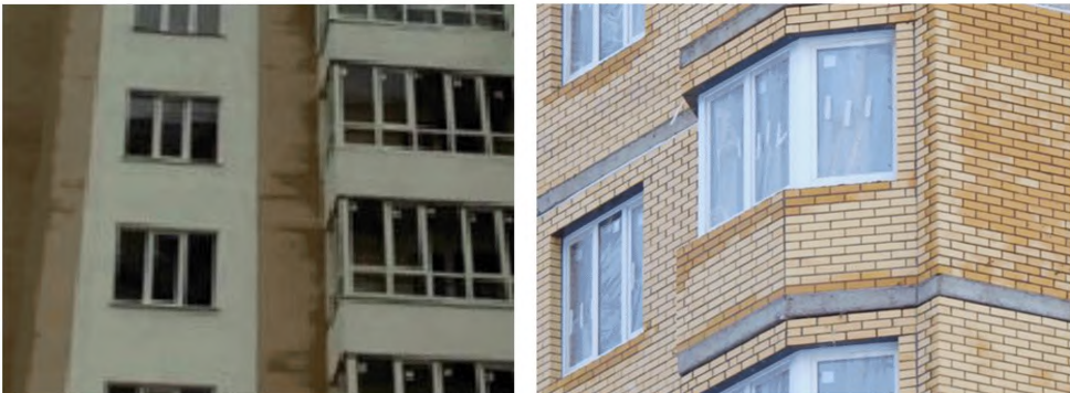
Рисунок А.1.15. Намокание облицовочного каменного слоя в зоне лоджий, балконов, подоконников и перекрытий
