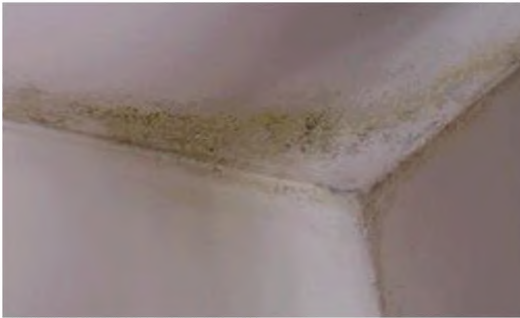
Рисунок А.1.17. Увлажнение внутри помещений из-за недостаточной теплоизоляции или протечек
