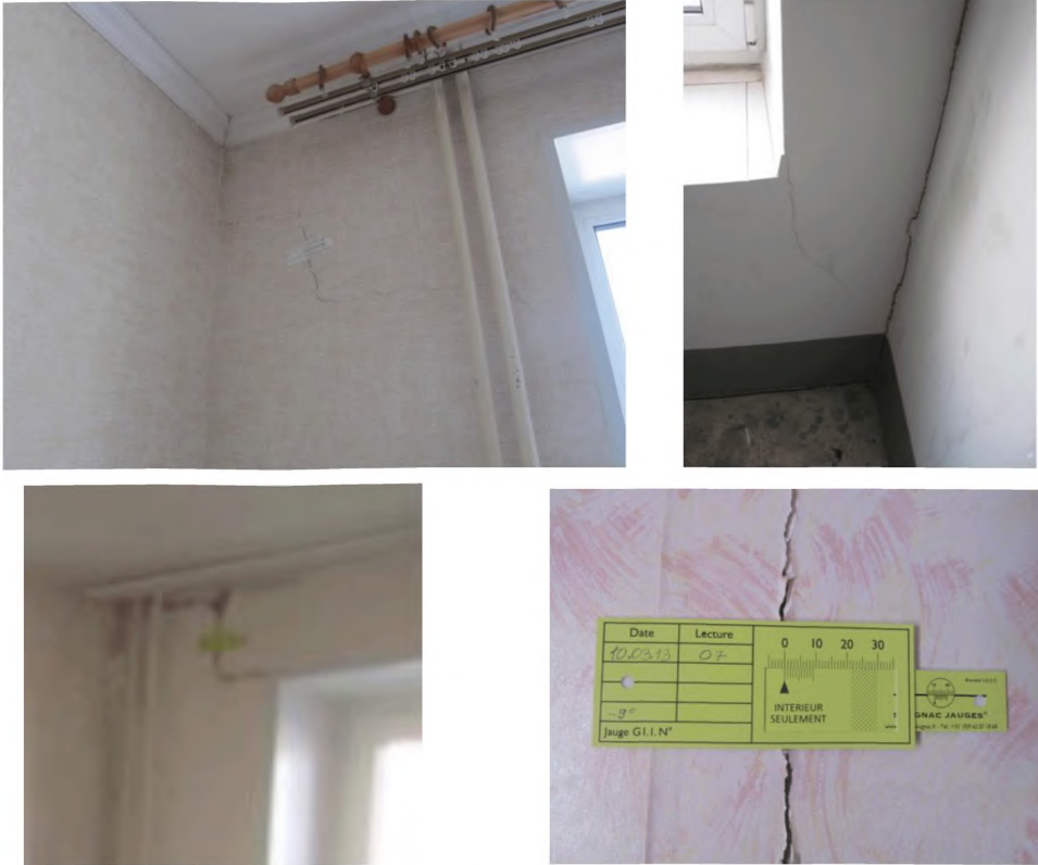
Рисунок А.1.19. Образование трещин во внутреннем каменном слое
