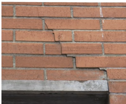
Рисунок А.1.7. Вертикальные и наклонные трещины в зоне железобетонных и стальных перемычек вследствие разности их температурных деформаций и каменной кладки
