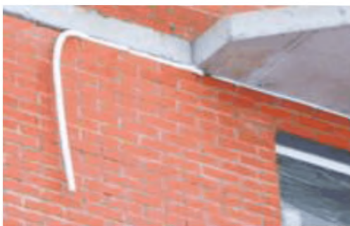
Рисунок А.2.4. Неправильная герметизация горизонтальных деформационных швов с внешней стороны облицовочного каменного слоя: а - заполнение кладочным раствором вместо податливого герметика, б - отсутствие герметика
