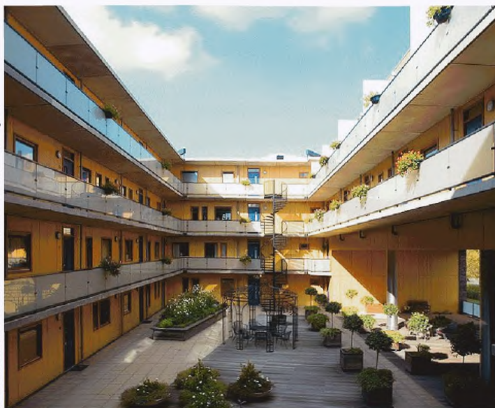
Галереи многосекционного дома выходят во двор и служат буферным пространством между ним и квартирами Het Binnenhof apartment building (Хемскерк, Нидерланды)
