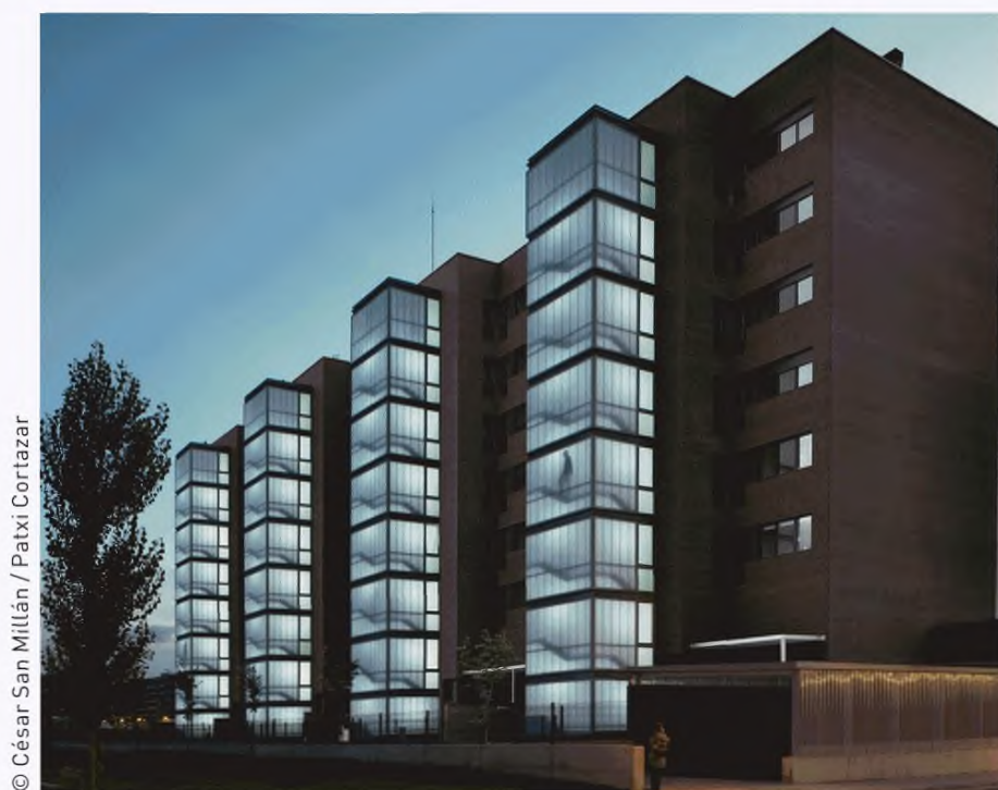
Лестничный узел как элемент решения фасада 56 Dwellings in Salburúa (Витория, Испания)
