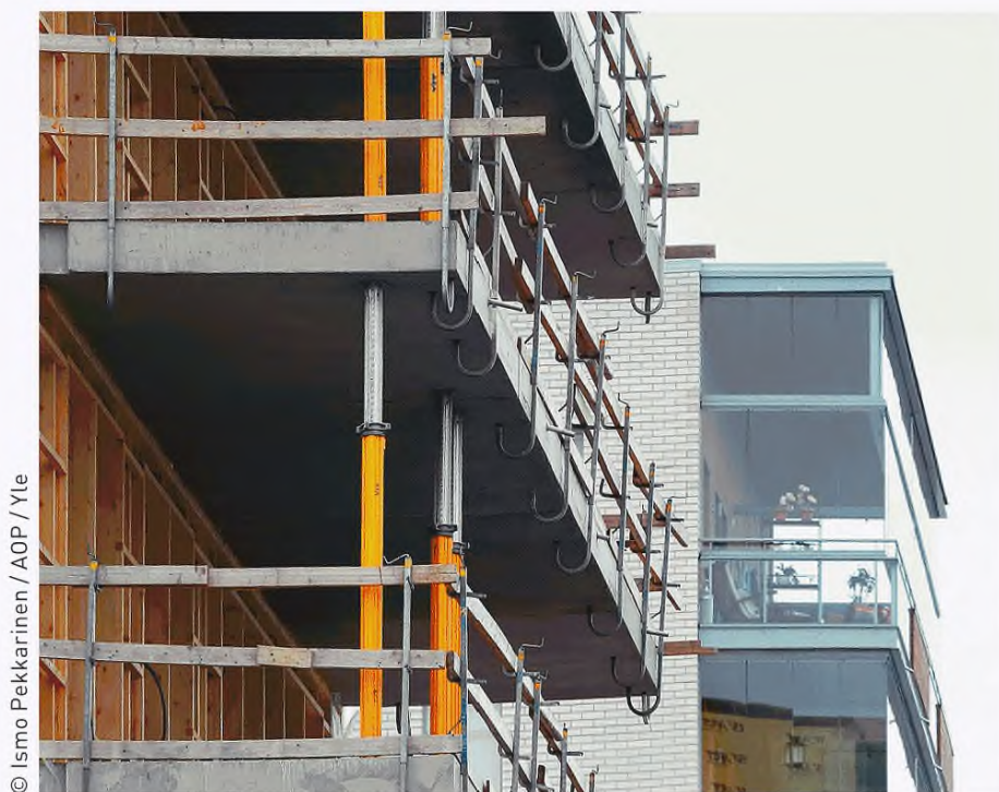
Внешняя стена и балконы из монолитного железобетона
