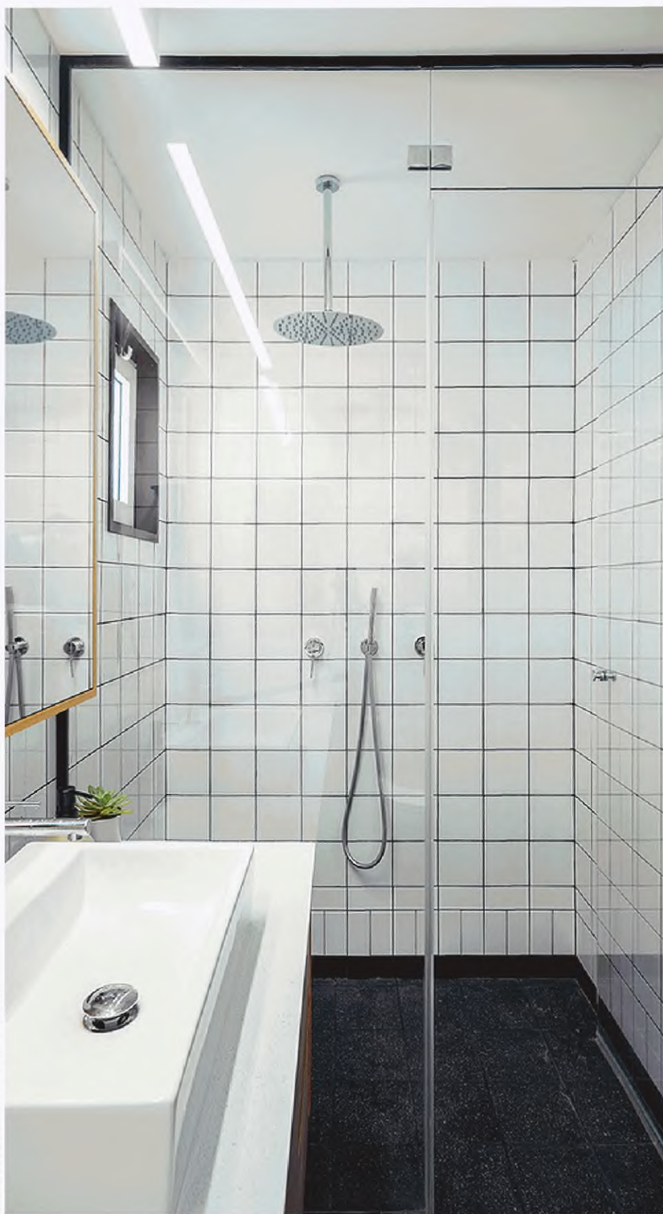
Встроенный душ со скрытыми в стенах инженерными системами White Raven Rooms (Тель-Авив, Израиль)
