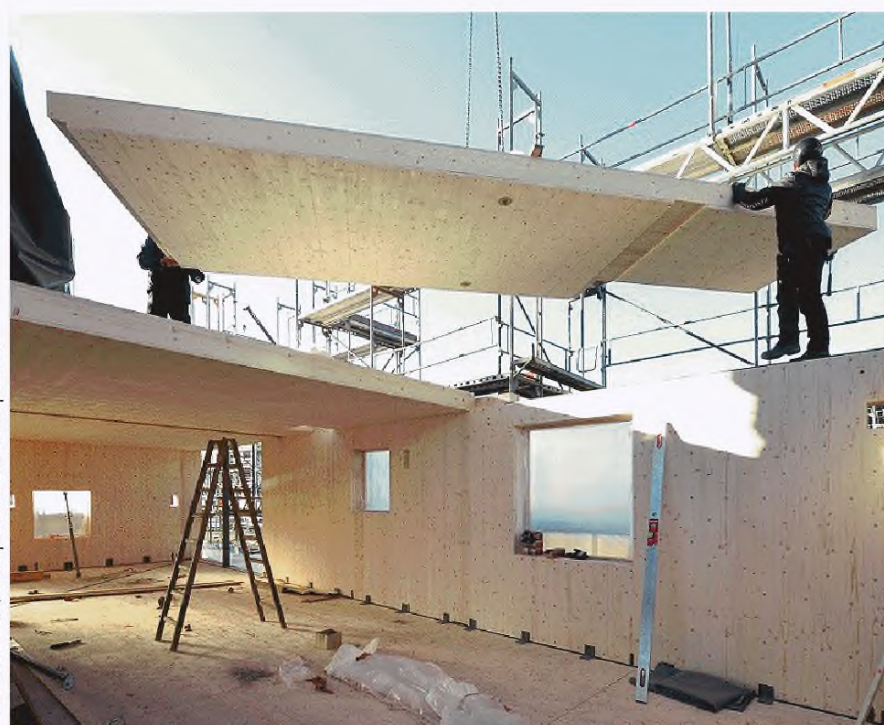
Деревянные панели перекрытия
