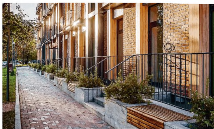
Индивидуальные входы в квартиры на первых этажах (Москва)
