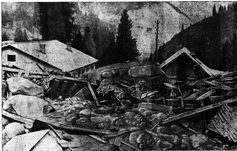
Рис. 3-21. Разрушение селем построек турбазы.
