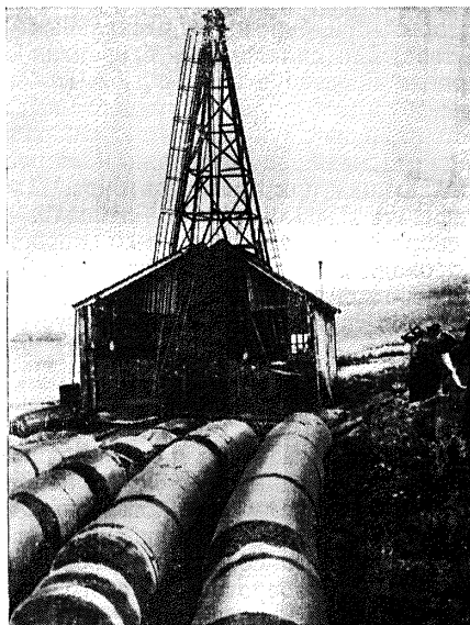
Рис. 5-21. Бурение смотровой скважины. На первом плане керн.
