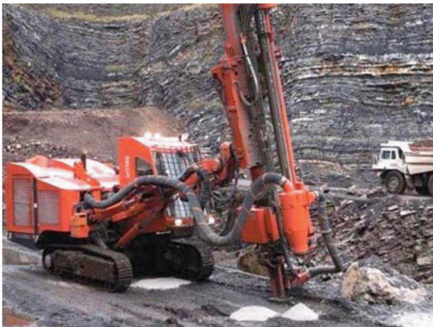
Рисунок 2.10 — Установка для бурения скважин
