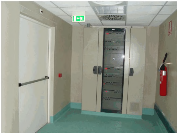
Рисунок 21 – Примеры дверей эвакуационных выходов с устройством «Антипаника»
