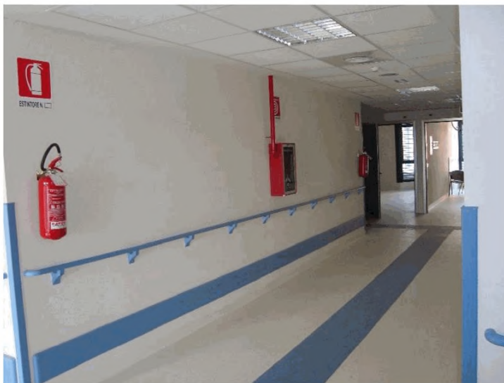
Рисунок 11 – Пример оборудования палатного отделения первичными средствами пожаротушения
