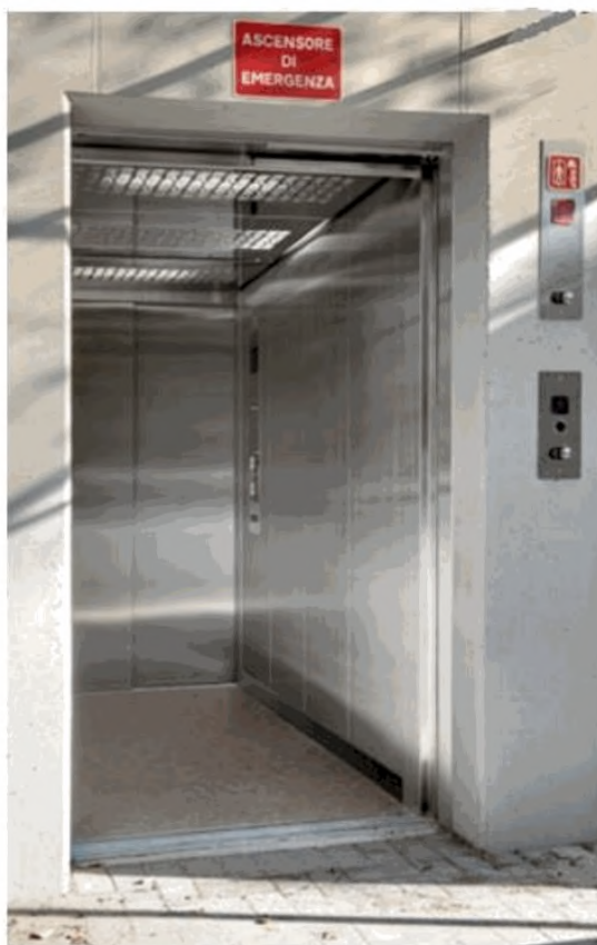
Рисунок 15 – Пример лифта для транспортирования пожарных подразделений с габаритами больничного лифта
