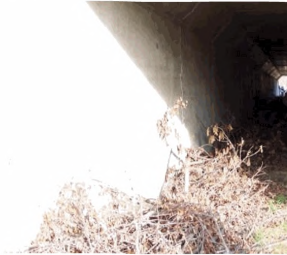
Рисунок 6 – Обустройство тоннелей вязанками хвороста
