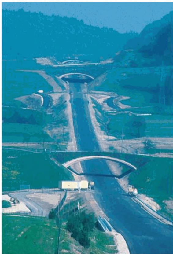
Рисунок 3 – Пример устройства последовательно расположенных надземных переходов
