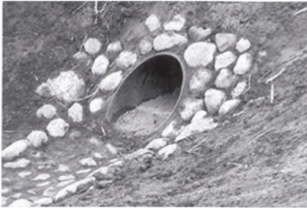
Рисунок 8 – Вход в тоннель для прохода мелких животных через дорогу
