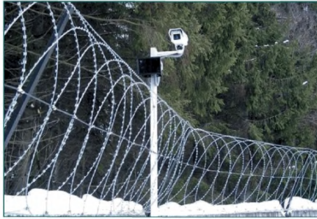
Рисунок 7. Установка ТК на столбе.
