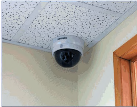
Рисунок 5. ТК устанавливаемая на подвесном потолке.
