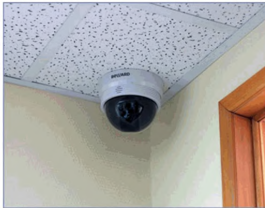
Рисунок 5. ТК устанавливаемая на подвесном потолке.
