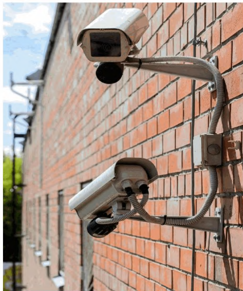
Рисунок 6. Установка ТК с ИК-проектором на стене здания.
