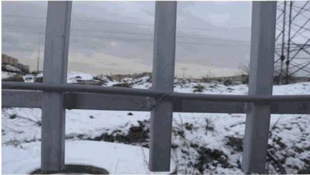
Рисунок 28. Установка ЧЭ на кованом заборе.
