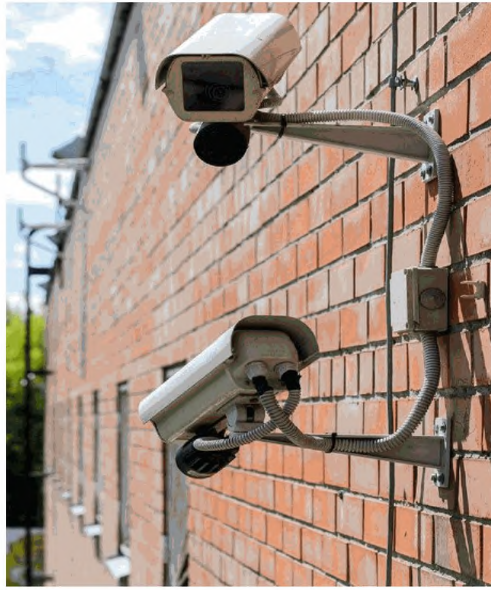
Рисунок 6. Установка ТК с ИК-прожектором на стене здания.
