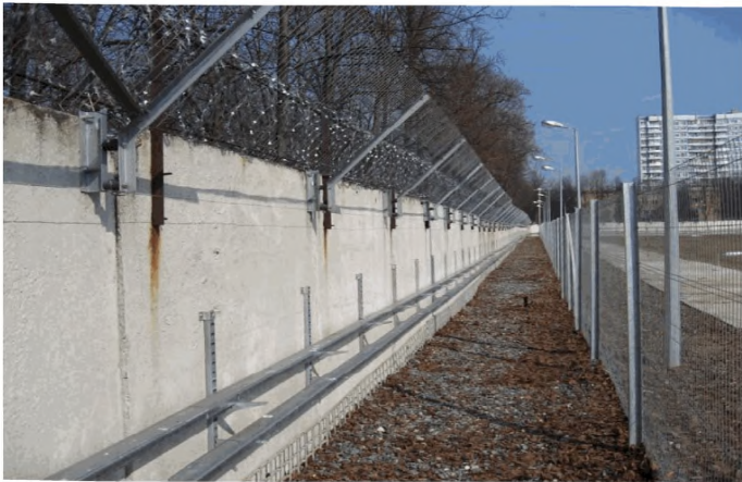
Рисунок 13. Инженерное оборудование периметра.
