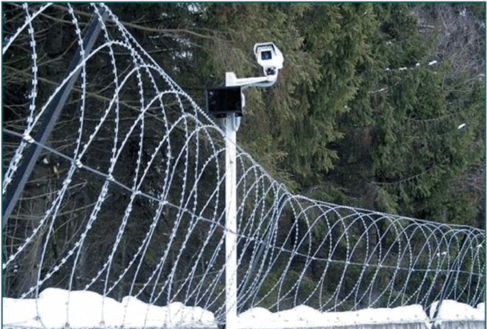
Рисунок 7. Установка ТК на столбе.
