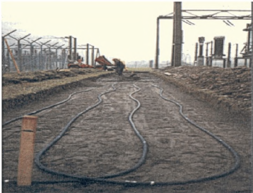
Рисунок 10. Установка чувствительного элемента (шлангов).
