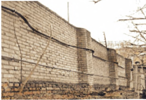
Рисунок 33. Установка ЧЭ на кирпичной стене.
