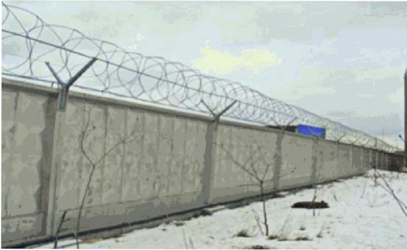
Рисунок 26. Бетонный забор с АКЛ.
