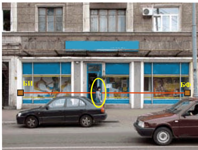
Рисунок 5.20 Не рекомендуемый вариант установки извещателя
