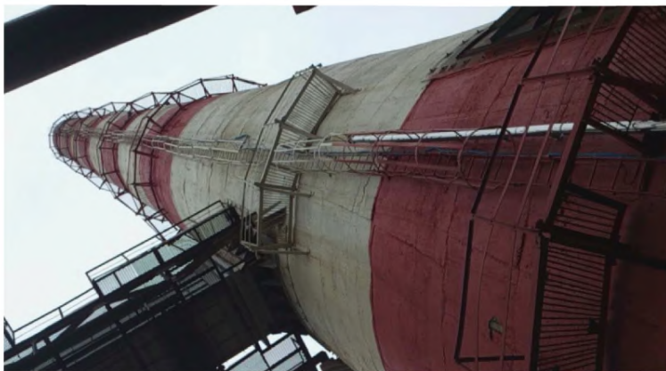
Рисунок 5.5 – Пример некорректного проектного решения: пробоотборная линия выше 60 метров с температурой подогрева ниже точки росы дымовых газов
