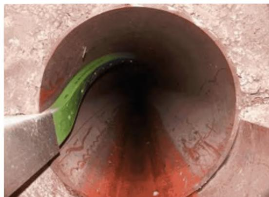
**Рисунок 32 – Прокладка микротрубочной канализации с помощью крепежа**
