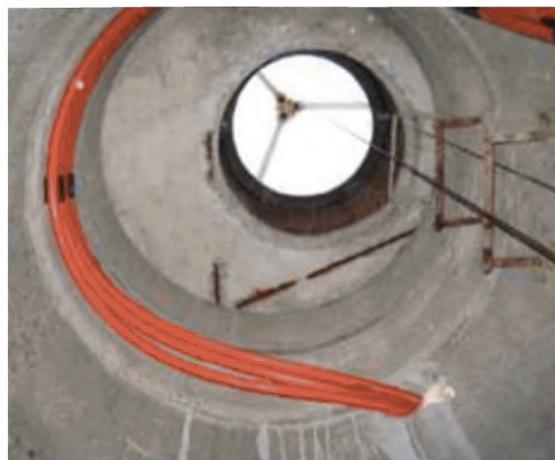
**Рисунок 33 – Вывод кабельных каналов в колодце**
