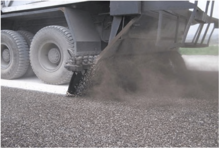
Рисунок 6.2 – Синхронное распределение вяжущего и щебня при устройстве поверхностной обработки
