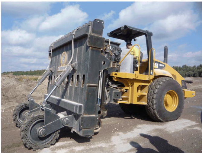
Рисунок 7.2 – Разрушение цементобетонного покрытия многомолотковым ударником
