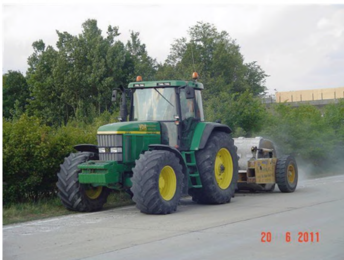
Рисунок 7.1 – Фрагментирование цементобетонного покрытия с применением импактора
