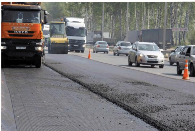
Рисунок 6.5 – Устройство верхнего асфальтобетонного слоя по слою геосетки
