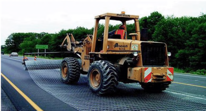
Рисунок 6.6 – Укладка стальной сетки
