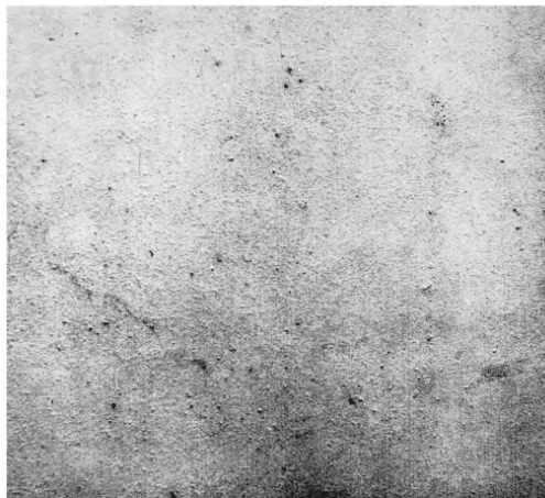
Рисунок 9 — Коррозия металла балл K1 (или Ri 1)
