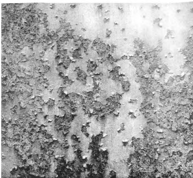
Рисунок 13 — Коррозия металла балл K5 (или Ri 5)
