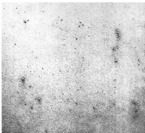
Рисунок 10 — Коррозия металла балл K2 (или Ri 2)
