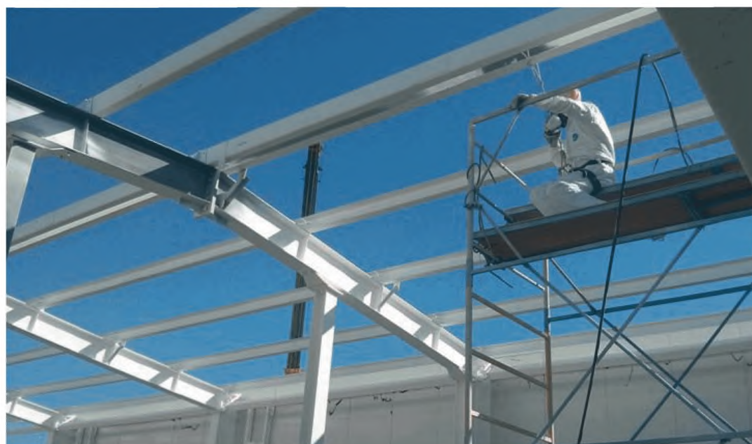
Рис. 1 Нанесение огнезащитных покрытий
