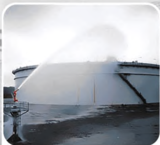
Защита резервуаров РВС-1000000, г.Новороссийск
