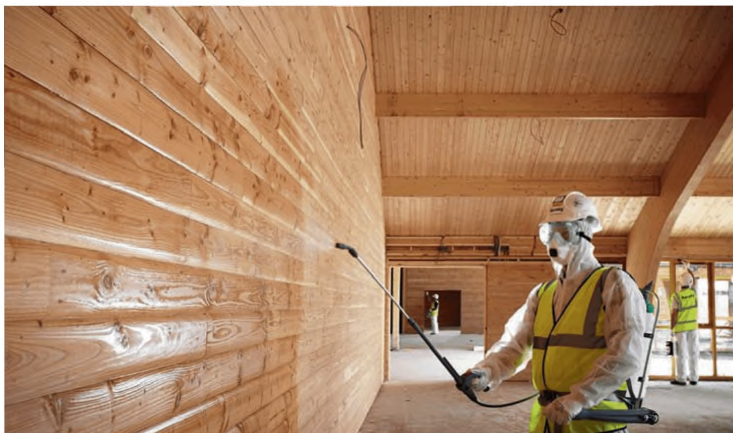
Нанесение огнезащитного состава для дерева
