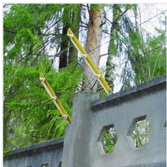
Рисунок 2.108 - ЧЭ комбинированного проводного извещателя "Дуэт"
