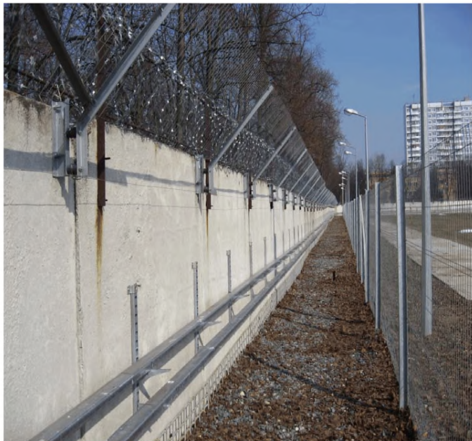
Рисунок 22 – Инженерное оборудование периметра
