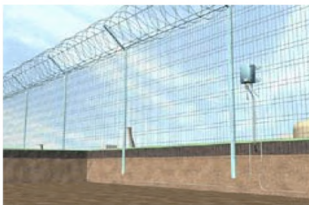
Рисунок 8 – Установка ЧЭ для определения подкопа
