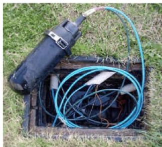
Рисунок 71 - Начальный модуль системы Secure Fence в подземном колодце
