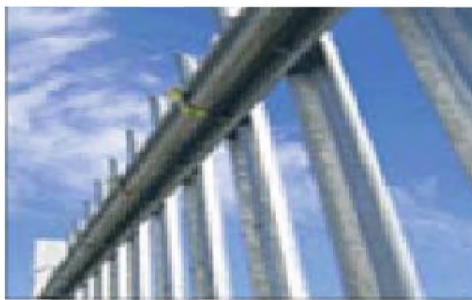
Рисунок 73 – Крепление сенсора на оградах из тяжелых стальных элементов
