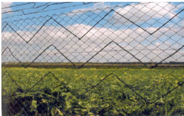
Рисунок 45 - Установка извещателя на сетке
