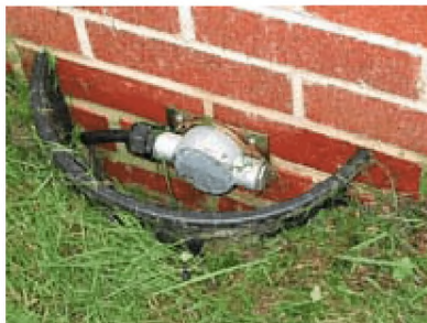
Рисунок 11 - Геофон под землей на кирпичной стене
