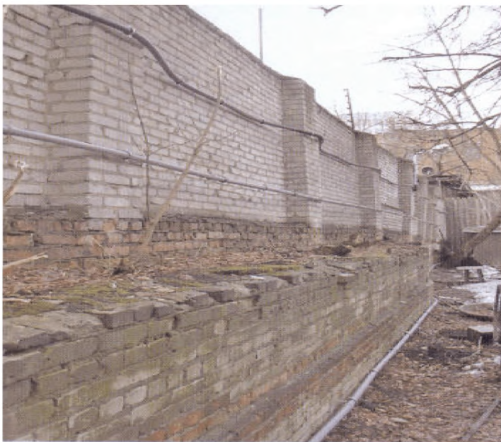
Рисунок 2.81 – Установка ЧЭ на кирпичной стене
