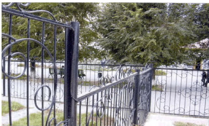
Рисунок 50 - Установка извещателя на сварных решетках
