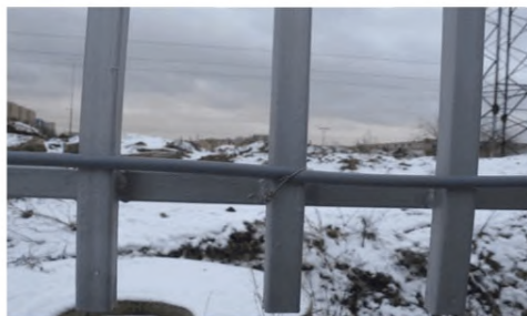
Рисунок 76 - Установка ЧЭ на кованом заборе
