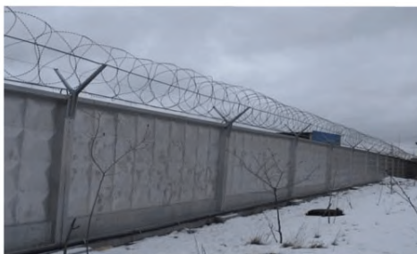
Рисунок 77 - Бетонный забор с АКЛ
