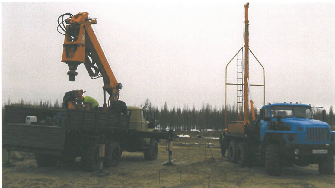
Рис.2.4 - Подготовка машины УБМ-85 (установка аутригеров, навеска патрона)
