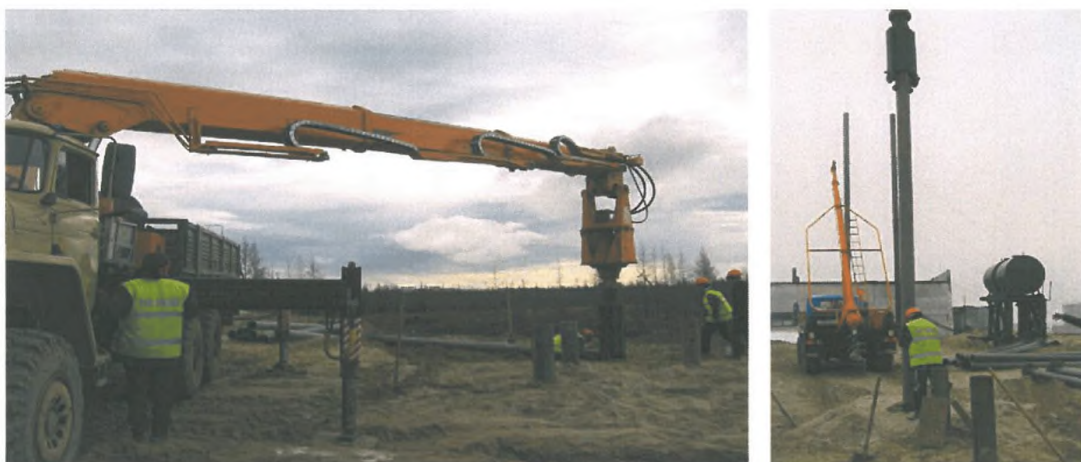
Рис.2.5 - Стрповка-захват головы сваи патроном, подъем, перемещение и вертикальное погружение свай в скважину-котлован
