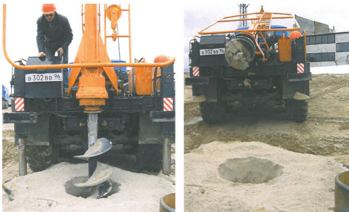
Рис. 2.3 - Бурение скважины (котлована) буром со шнеком диаметром 500 мм в сезонно-мёрзлых песчаных грунтах на глубину до 5,0 м (БКМ-515); светлые объёмы – мерзлый разбуренный песчаный грунт
