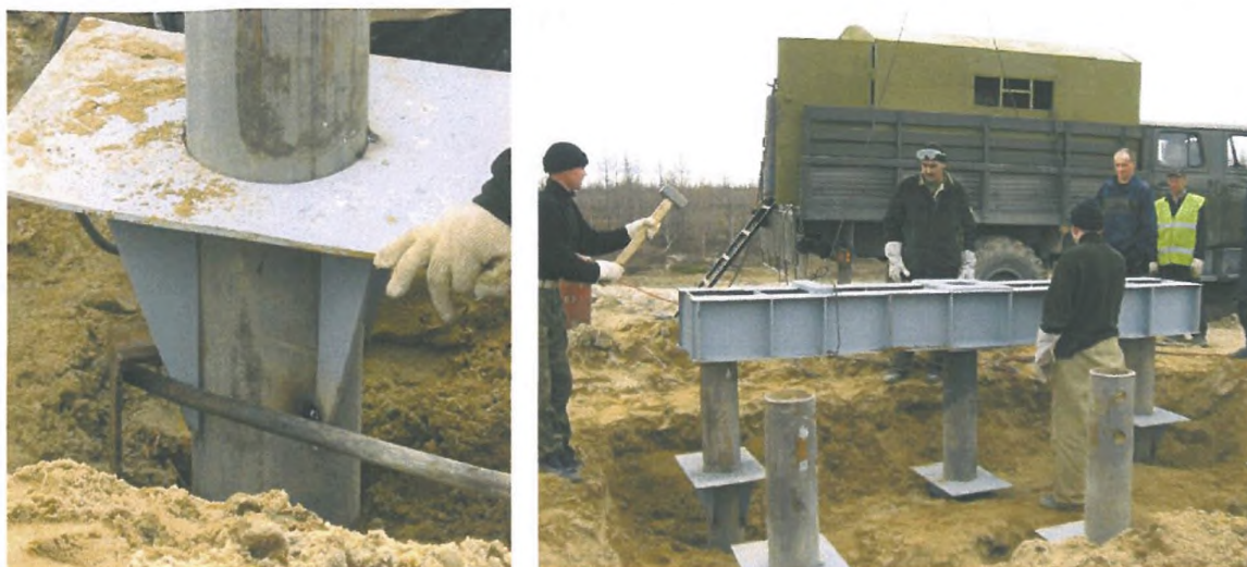
Рис.2.10 - Выполнение прихваточных сварных швов; установка балок нижнего уровня ростверка (на заднем плане – двухкабинный Урал 4320-31 с дизельным сварочным агрегатом АДД для сварки в полевых условиях)
