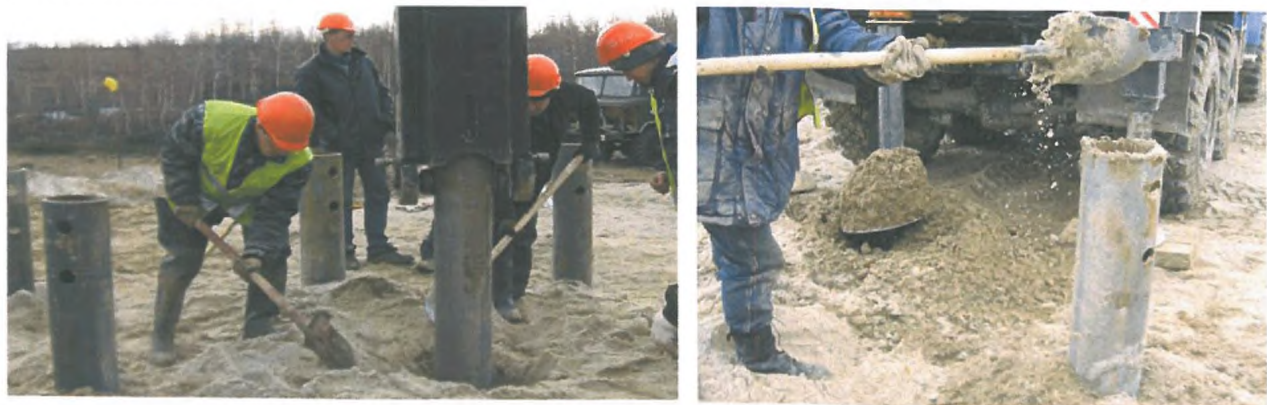
Рис.2.8 - Засыпка пазухи и внутренней полости винтовой сваи
