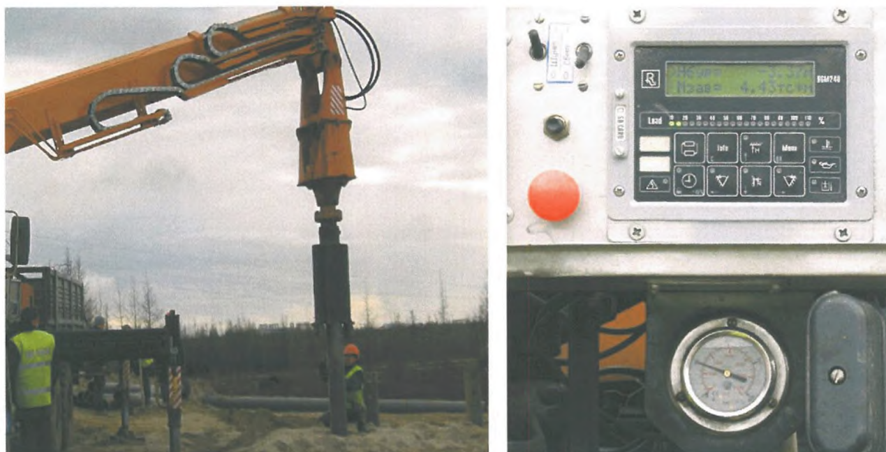
Рис.2.6 - Завинчивание сваи с контролем вертикальности; приборный щиток
