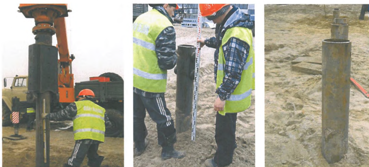
Рис. 2.7 - Контроль вертикальности завинчиваемой сваи; контроль вертикальной отметки сваи; ряд завинченных свай, имеющих отклонения по горизонтали и вертикали
