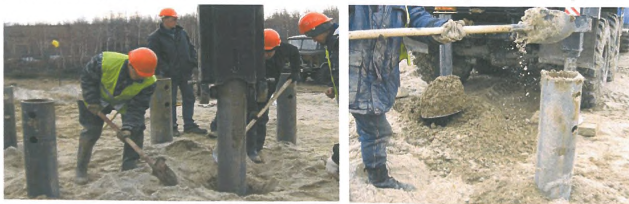
Рис.2.8 - Засыпка пазухи и внутренней полости винтовой сваи
