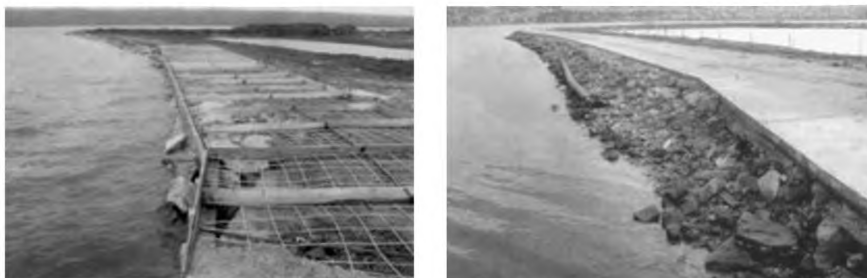
Рисунок 8.23 – Сооружение бунны с использованием композитной арматуры 1)
