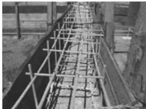
Рисунок 8.6 – Армирование фундамента по периметру сооружения
