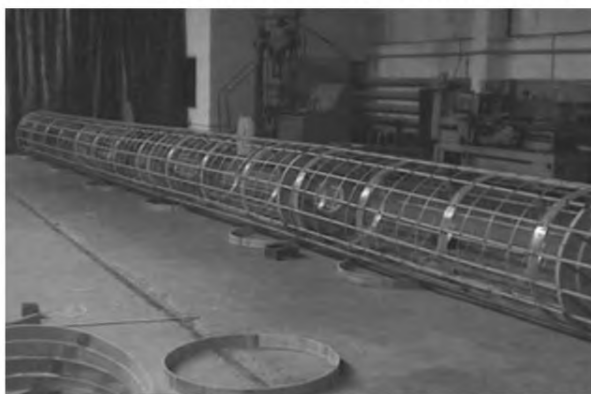
Рисунок 8.29 – Каркас буронабивной сваи из АНК-С в сборе
