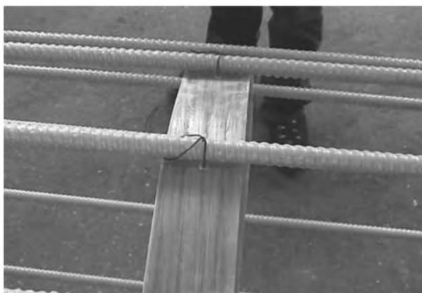
Рисунок 8.30 – Деталь крепления рабочего стержня АНК-С к кольцу жесткости
