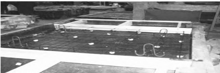
Рисунок 6.2 – Общий вид арматурных каркасов (сеток), уложенных в опалубочную форму опытного образца дорожной плиты
