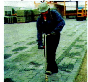
Направляющий лом для выравнивания рядов
