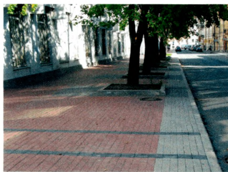
Мощение тротуара. Выделение цветными полосами из черного камня входных групп в здание (3-я Краноармейская ул., Санкт-Петербург)
