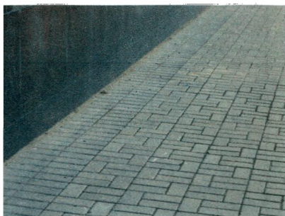
Рисунок 5.4 - Цветовые различия между искусственными камнями серого и черного цвета в сухую погоду слаборазличимы
