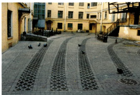
Комбинация камней мощения и плит (Санкт-Петербург, дворовая территория на наб. канала Грибоедова)
