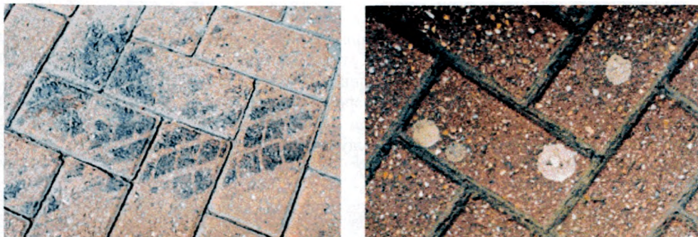
Рисунок 9.3 — Следы загрязнений на поверхности камней
