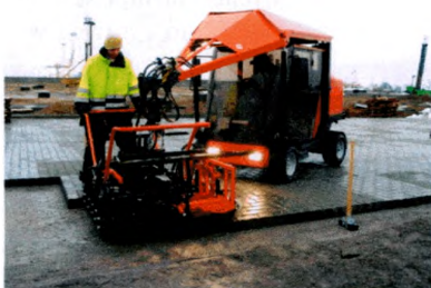
Машина “ОПТИМАС” для укладки камней
