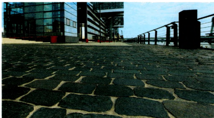
Рисунок 5.20 – Общий вид дорожного покрытия выполненного с использованием растворов на основе трассово-цементных вяжущих
