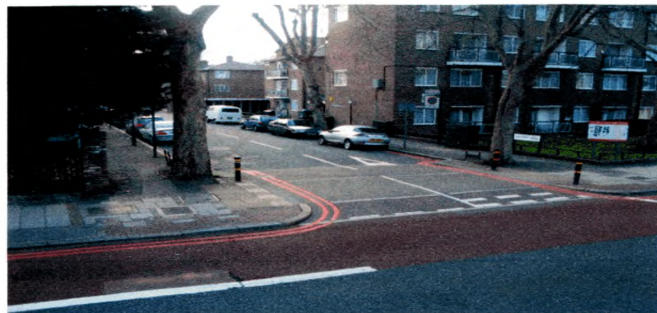
Рисунок 5.14 – Приподнятый пешеходный переход на въезде в жилую зону
