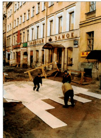
Рисунок 6.2 – Применение экструдированного пенополистирола при устройстве дорожной одежды
