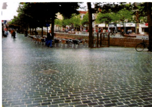
Рисунок 5.19 – Заполнение швов контрастным раствором в дорожном покрытии из натуральных камней черного цвета
