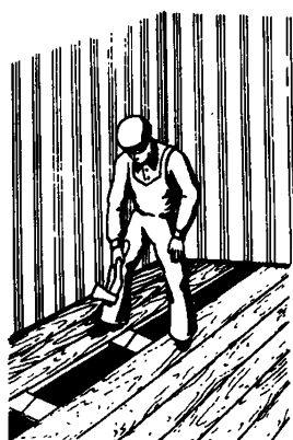
Рис. 91. Сплачивание рядовых досок
