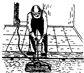
Рис. 52. Бетонирование плиты монолитного перекрытия
