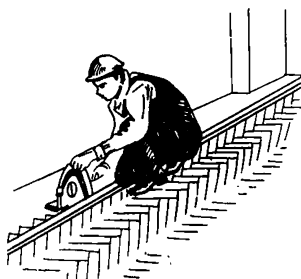
Рис. 83. Обрезка предфризового ряда
