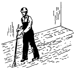
Рис. 44. Очистка поверхности плиты от грязи
