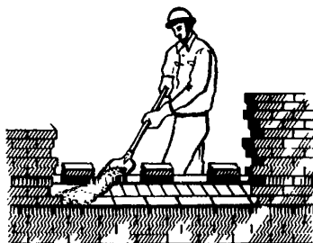
Рис. 16. Расстиление раствора для ложкового ряда наружной версты
