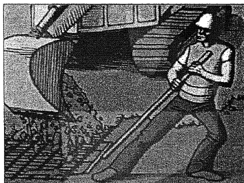
Рисунок 41 – Натяжение георешетки перед засыпкой
