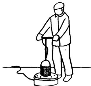
Маляр  $M_3$  включает шлифовальную машину и обрабатывает поверхность основания в местах расширенных и заделанных трещин ( в труднодоступных местах он выполняет эту операцию скребком )
