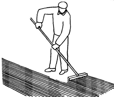
Маляры  $M_2$  и  $M_3$  швабрами разравнивают огрунтовочный состав по всей поверхности, не допуская образования луж и просветов
