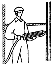
При герметизации стыка наружной стеновой панели
