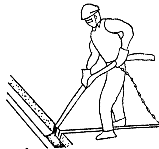
Бетонщик БЗ уплотняет вибратором бетонную смесь в стыке
