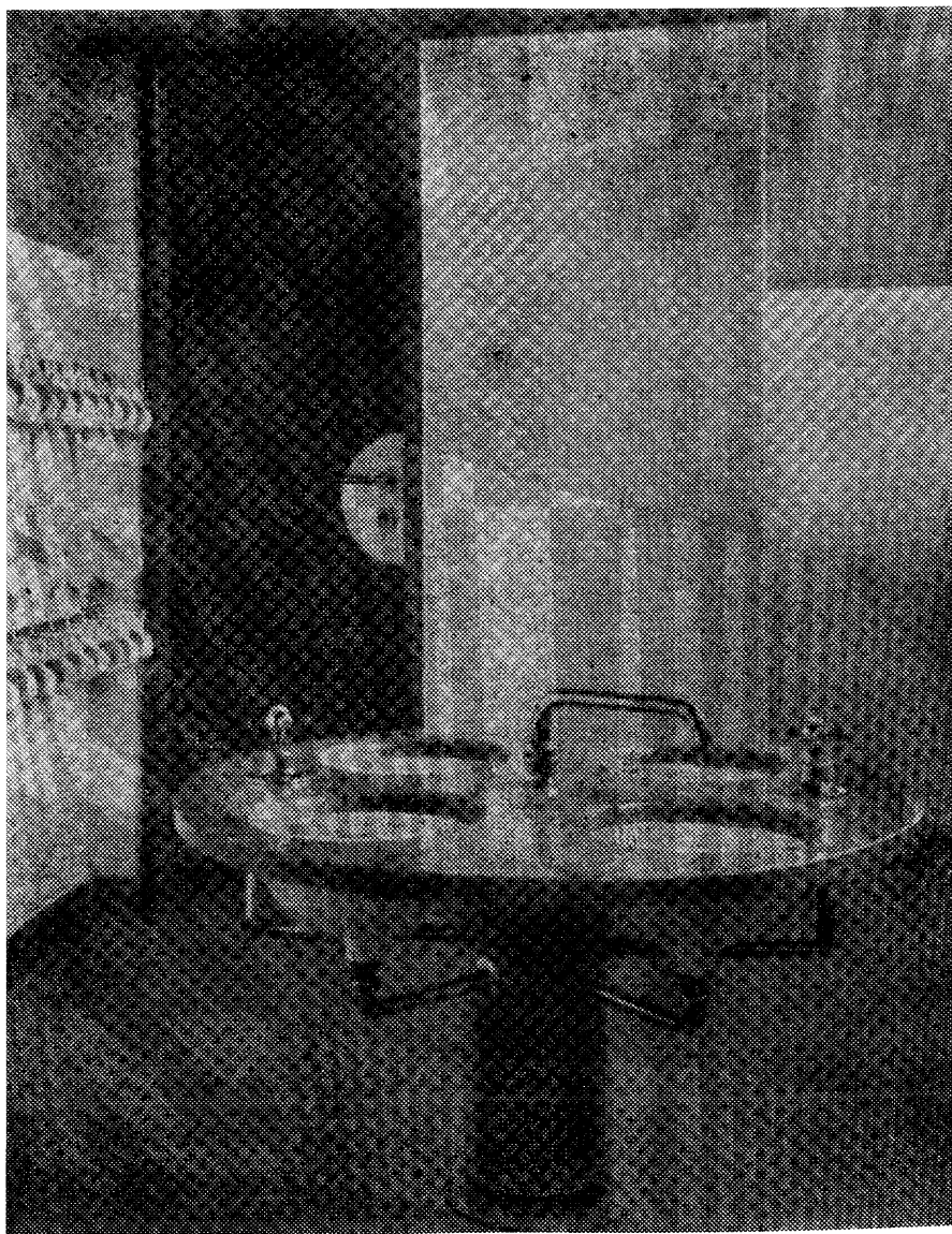
Рис. 28. Интерьер умывальной с размещением умывальников в центре помещения
