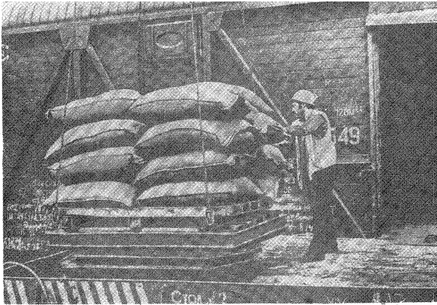
Рис.105.1. Пакет сахара-сырца на гребенчатом поддоне. Порт Николаев.
