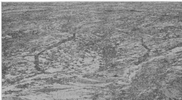
Рис 29. Провальные воронки на откосе намыва золошлакоотвала Интинской ТЭЦ в результате оттаивания мерзлоты и замывого льда (июль, 1980 г.).
