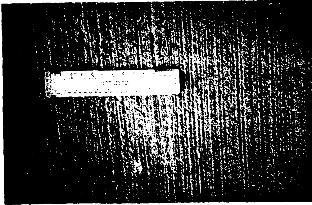
Рис. 5-7. Новое бетонное покрытие, обработанное проволочной щеткой
