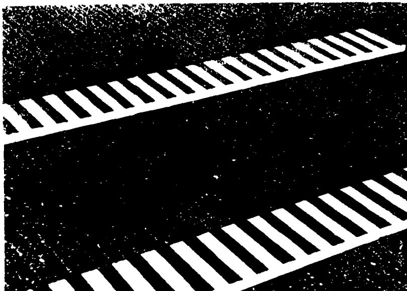
Рис. 5-4 Рифление асфальтового покрытия
