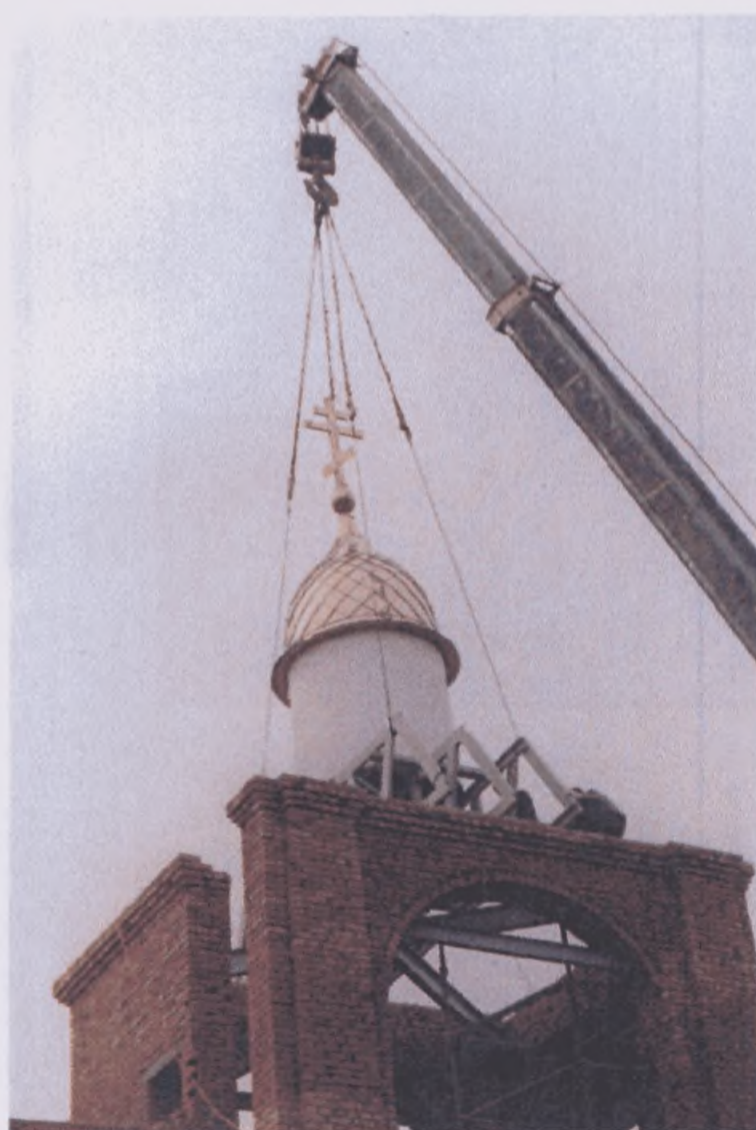
Монтаж венчающей части звонницы
