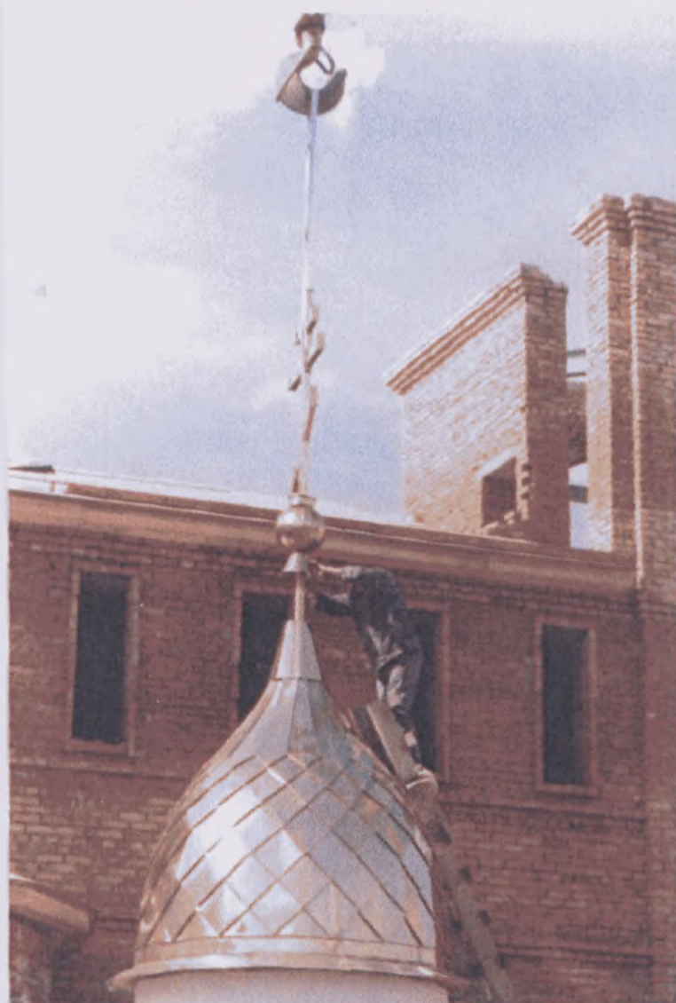
Монтаж венчающей части звонницы
